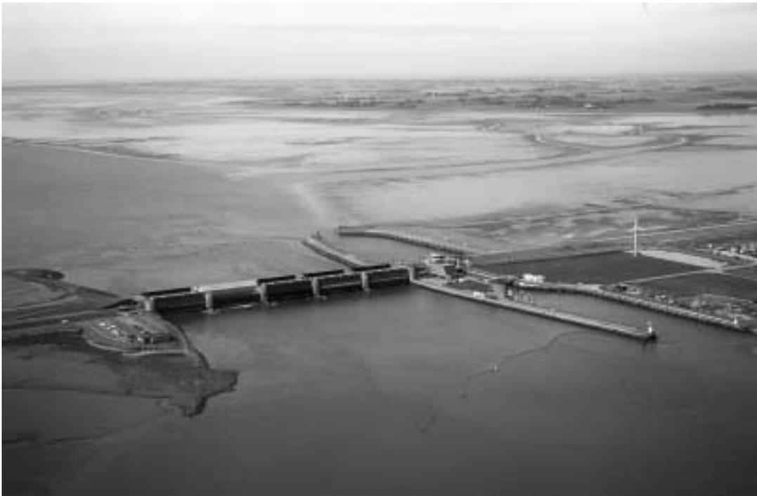
**Abbildung 2: Blick von Süd-Ost auf das Eidersperrwerk bei Niedrigwasser. Erkennbar ist das Sielbauwerk mit fünf Wehrtoren und die Schifffahrtsschleuse mit den see- und binnenseitigen Vorhäfen. Seeseitig schließen sich die Wattflächen der Außeneider an. (Photo von Norbert Kempf, 1997)**
