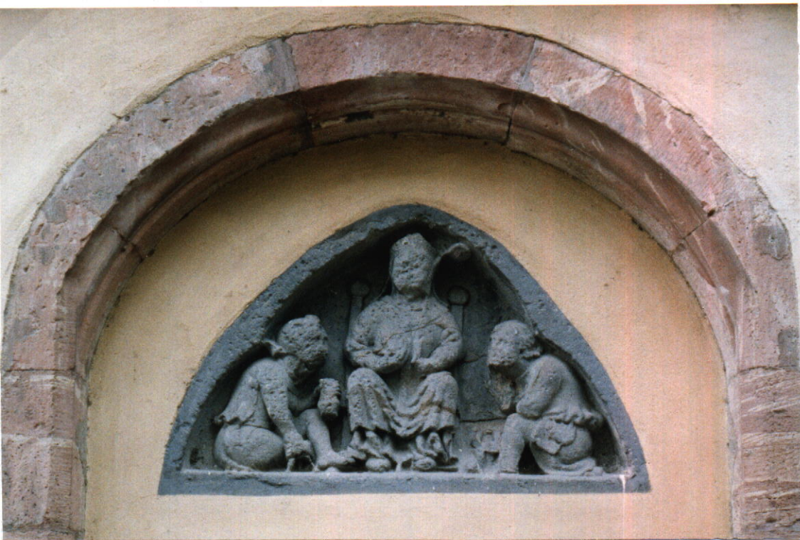
183 Tympanon Frankfurt/M., St. Nikolai, Südseite
