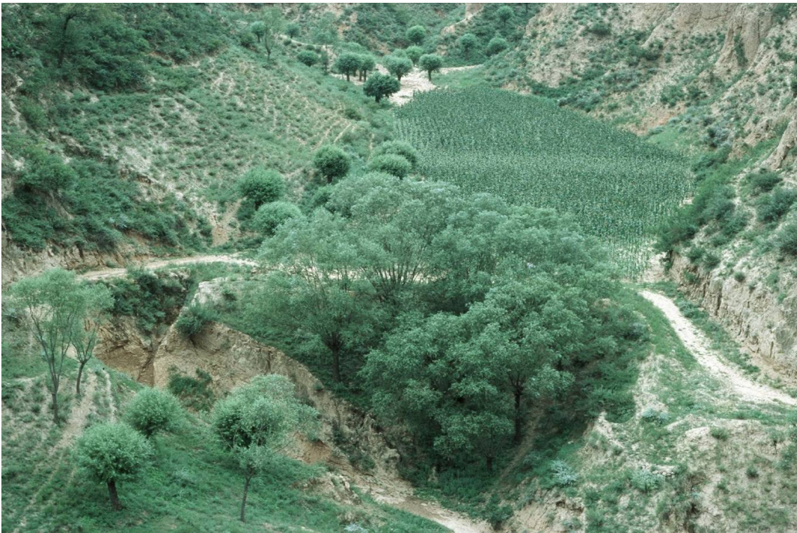
Abb. 18: Zerschluchteter Guzhuangzi-Damm und mit Sediment verfülltes Reservoir XI in Yangjuangou. Foto: BORK 2001
