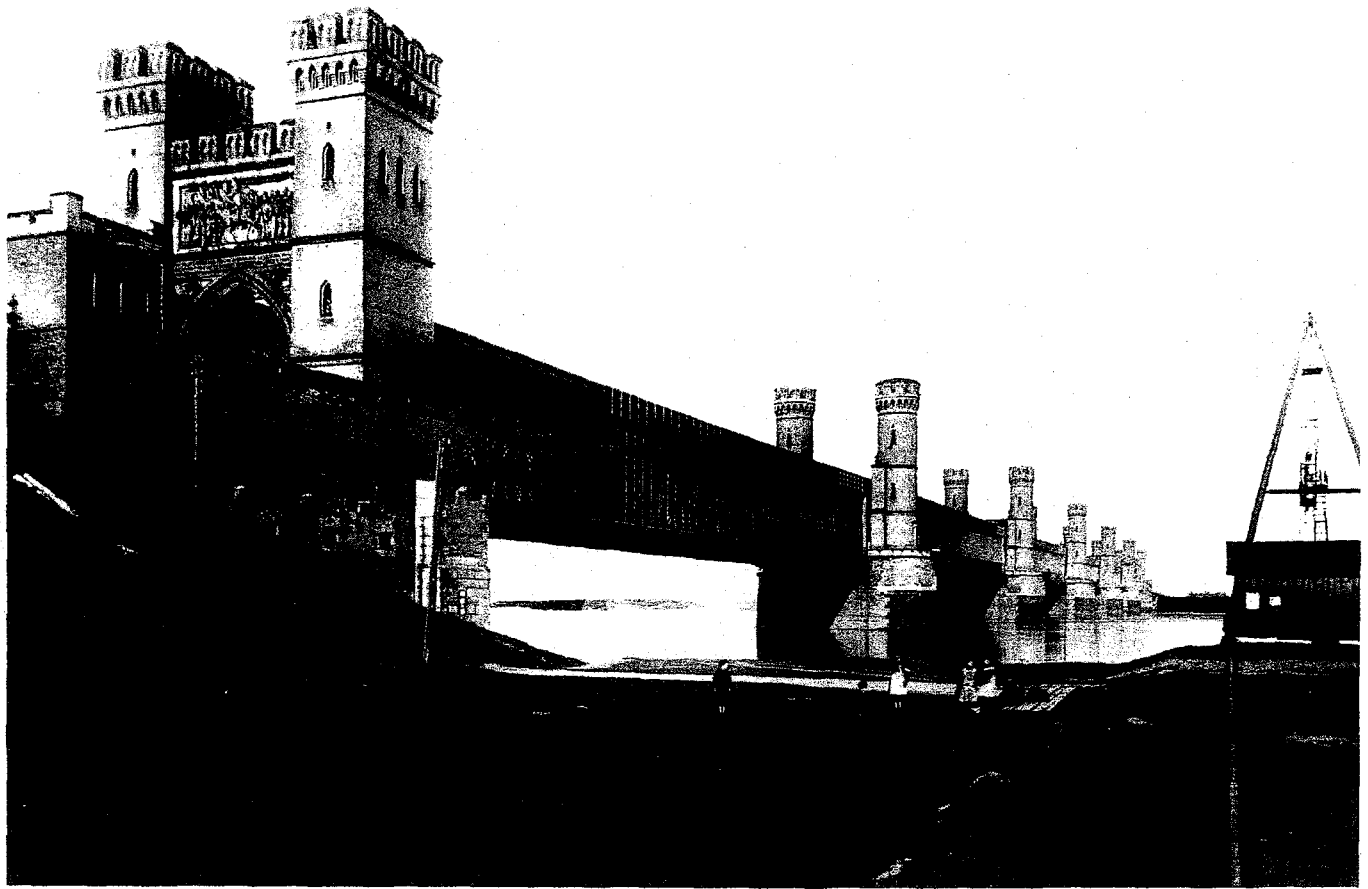
Abb. 23 Die Eisenbahnbrücke über die Weichsel bei Dirschau von Westen.
