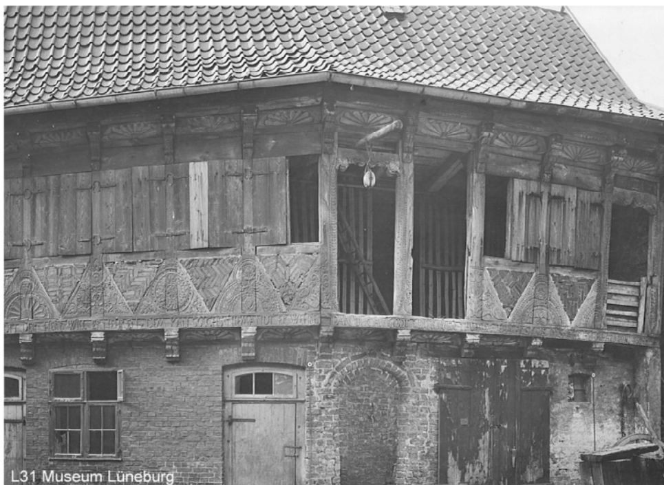
Abb. 174 Lüner Straße 5, 1594 (i), Hoftraufseite mit deutlichem Knick im GR, Muschelfüllhölzer, alte Fotografie, nach 1906 abgebrochen
