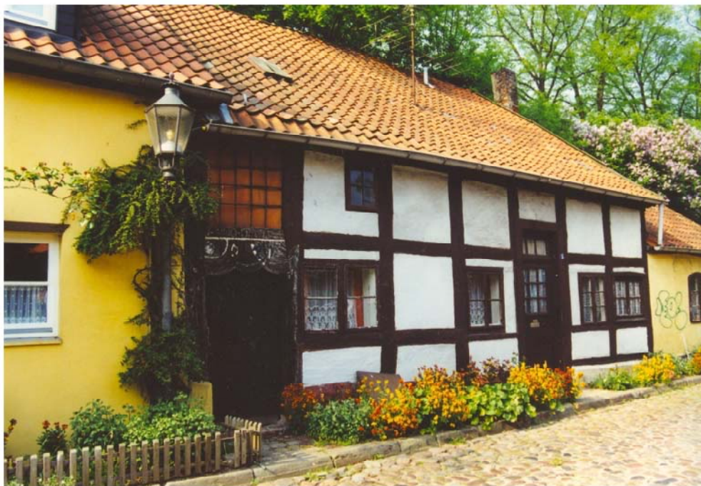
Abb. 156 Hinter der Bardowicker Mauer 5, 1544 (i/d), Fahrtknechtshaus, S-Trauffassade, Zustand 2000
