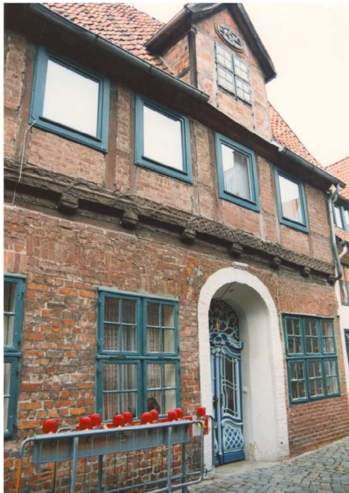
Abb. 84 Auf dem Meere 17, 1562 (d), S-Trauf- fassade, Schwelle mit Laubstab und vierfachem Flecht- band
