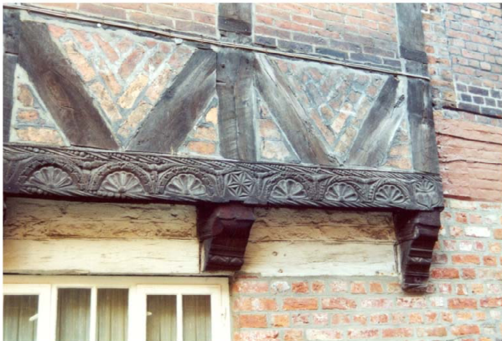
Abb. 172 Lüner Straße 3, 1546 (i), Schwelle mit gedrehten Perl- stäben und Tauband, Muschelrosetten und dreiblät- tigen Blüten in den Zwickeln, Wappen (Rübe?)
