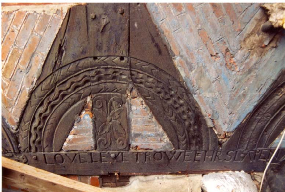
Abb. 127 Grapengießerstraße 12, Flügelbau 1572 (i), Detail: beschnittene Fußhölzer
