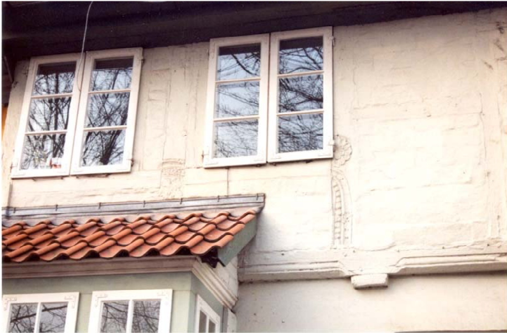
Abb. 189 Ritterstraße 4, n.d., Detail: Schwelle mit Bügelfries und Schiffskehle, Reste von Schmuckbandbeschnitzung
