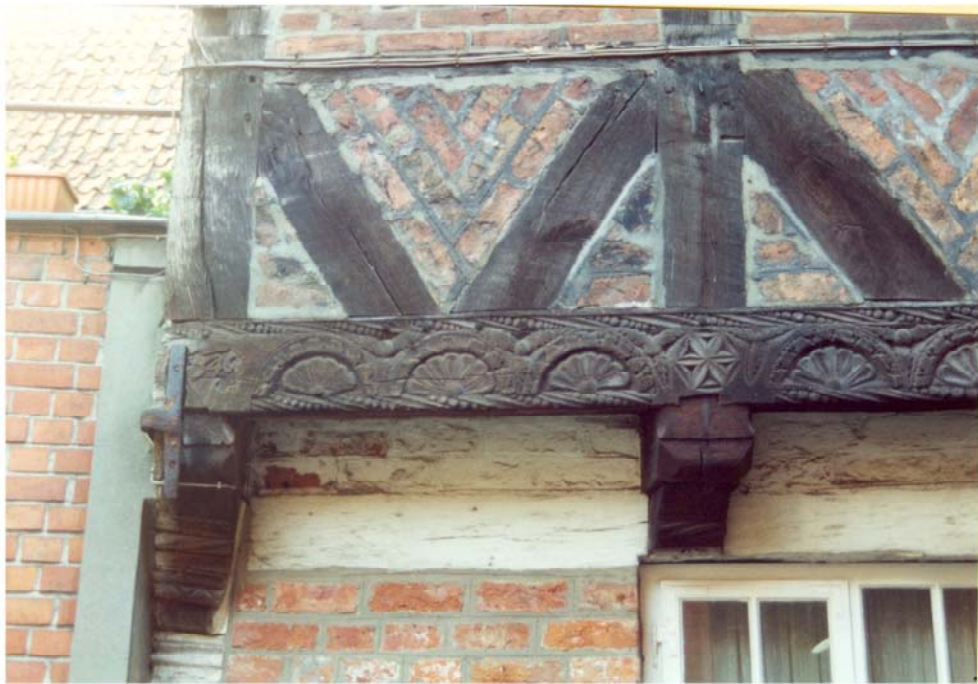
Abb. 171 Lüner Straße 3, 1546 (i), O-Traufwand, 1. FW-Stockwerk, Fußstreben, Schwelle mit Datierung, Taubandknaggen
