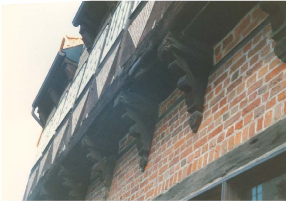
Abb. 76 Auf dem Kauf 6, n.d., Detail: Wulstbügen
