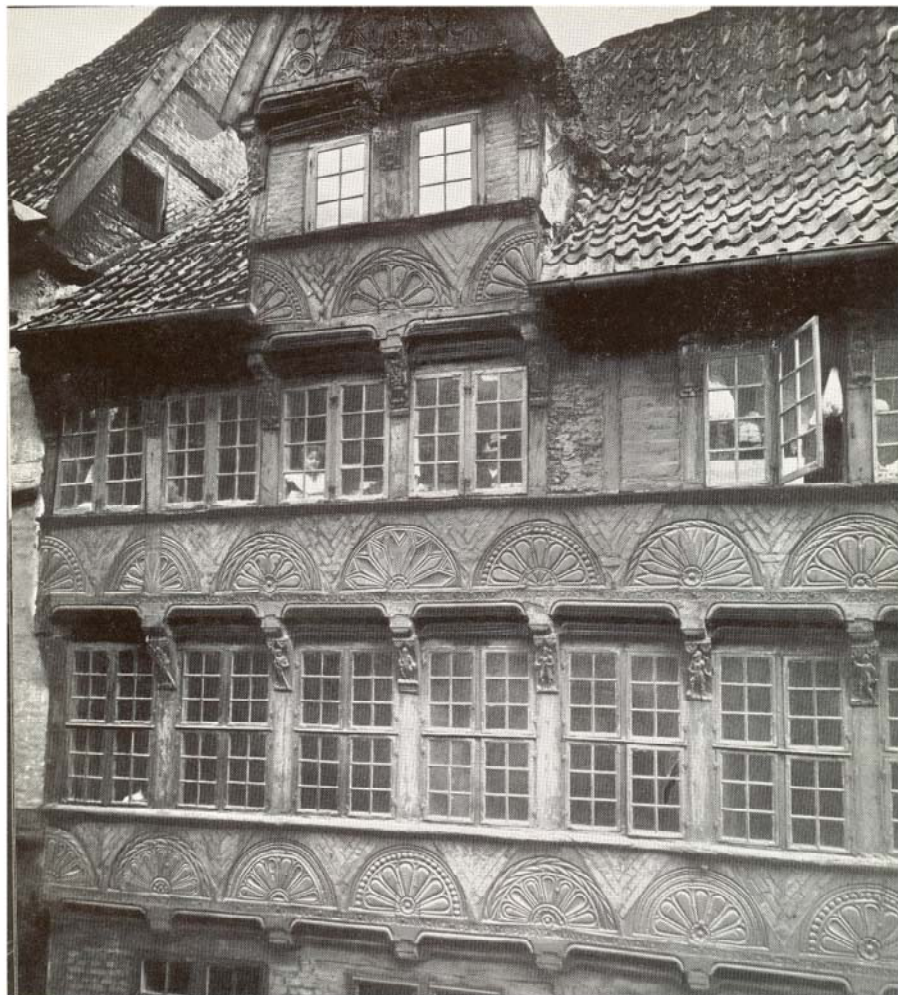
Abb. 33 Kiel, Haßstraße 1, 1576 (i), n.e., Figurenknaggen, Schiffskehlen, Muschel- und Fächerrosetten, Tau- und Schmuckbänder, Zierverbände
