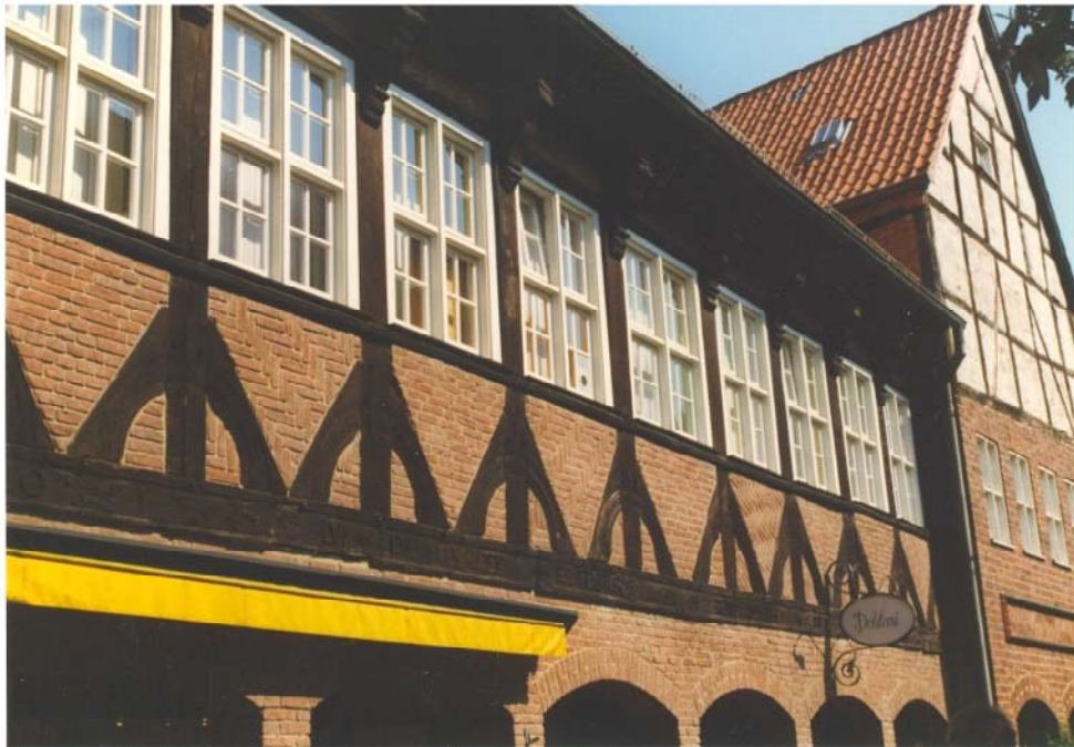
Abb. 149 Große Bäckerstraße 18, 1543 (i), Flügelbau, 1543 (i), erneuert 1973, S-Trauffassade
