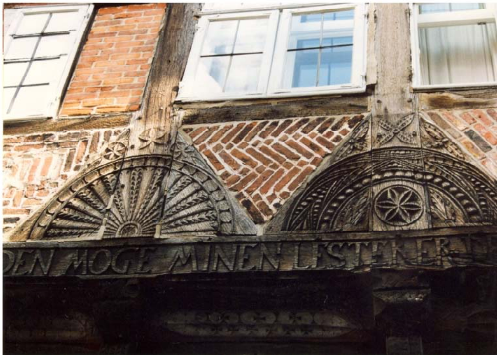
Abb. 123 Grapengießersstraße 5, um 1583 (d), Detail: Fußwinkelhölzer
