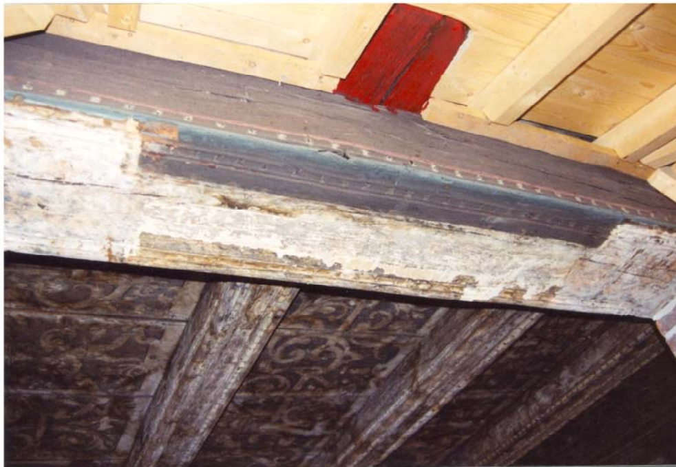
Abb. 96 Obere Ohlingerstraße, 1593 (i), Sturzbalken des ehemaligen Erkers des Saals, Zustand 2004 während der Rekonstruktion
