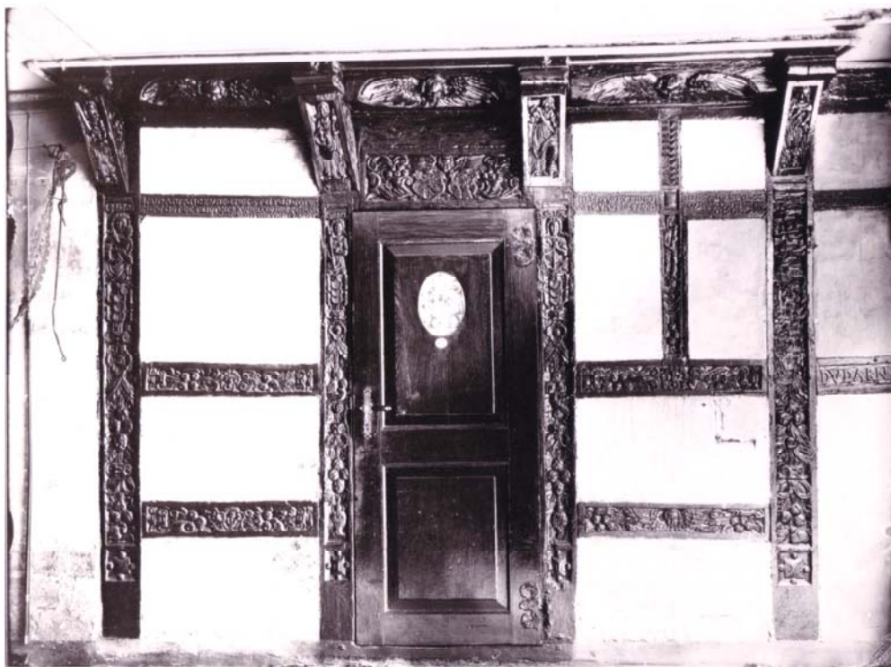
Abb. 45 Am Berge 13, 1615 (i), FW-Wand in einer Durchfahrt, n.e., alte Fotografie
