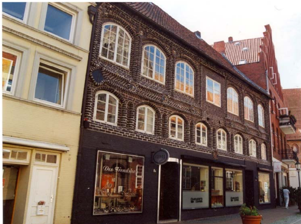
Abb. 15 An der Münze 8, 1546 (i), Spuren eines Erkers
