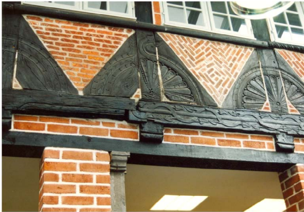
Abb. 131 Grapengießerstraße 13, Flügelbau, n.d., Detail: Anstückung zweier unterschiedlicher Schwellen mit einfachem, geradem Blatt
