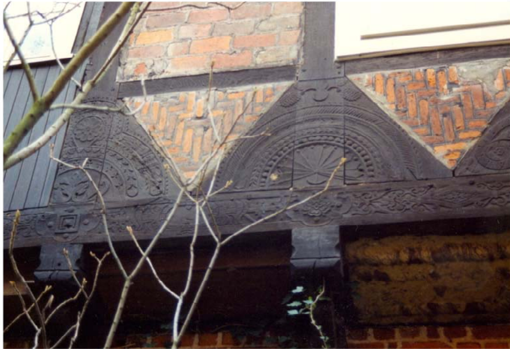
Abb. 141 Grapengießer- straÙe 45, Detail: Schwelle und Fuß- winkelhölzer
