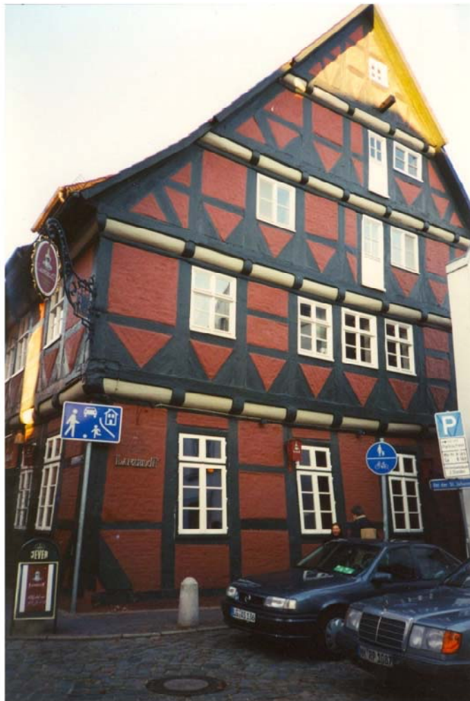
Abb. 213 Wandfärberstraße 7 S-O-Ecke und S- Giebelfassade
