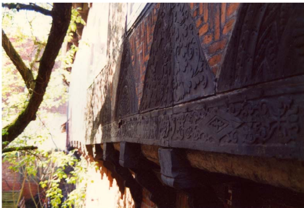
Abb. 143 Grapengießerstraße 45, Detail: Schwelle und Fußwinkelhölzer
