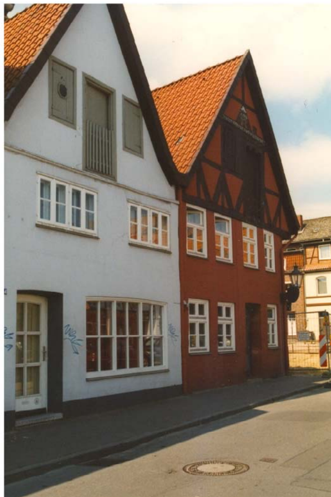
Abb. 162 Im Wendischen Dorfe 24 und 23, O-Giebfassaden
