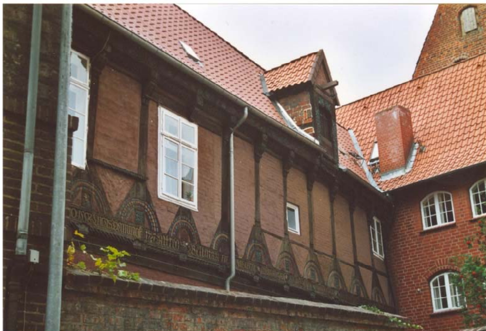
Abb. 146 Große Bäcker- straße 15, 1558 (i), Flügelbau, N-Trauf- seite, FW-Stockwerk
