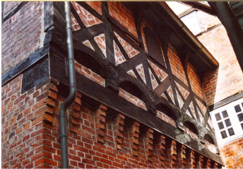
Abb. 155 Heiligengeiststraße 33, Hofflügel, n.d., Detail: Eckkonstruktion, Bogenfries mit Blütenkreisen dazwischen, Andreaskreuze
