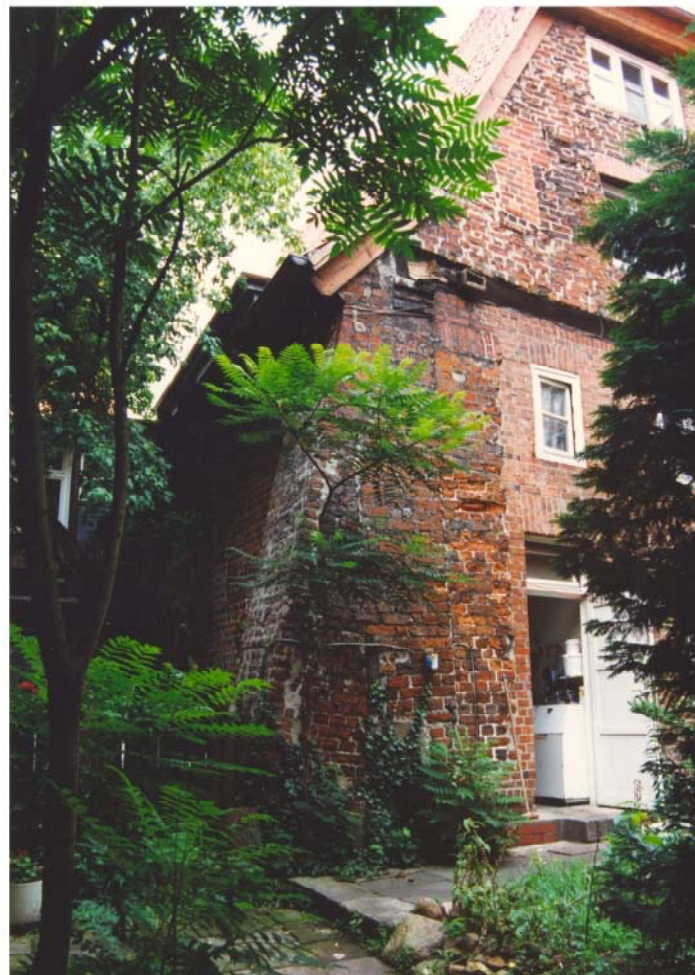
Abb. 138 Grapengießer- straße 45, Haupt- gebäude, rückwär- tige S-Giebelfassade, S-W-Ecke
