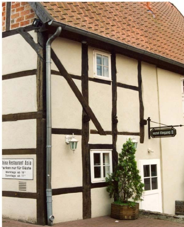
Abb. 13 Altenbrückertor- straße 11 / 12, Gefüge 1535 (d), Dach 1655 / 1656 (d), N-O-Ecke mit Schwertung und Zapfenschlössern
