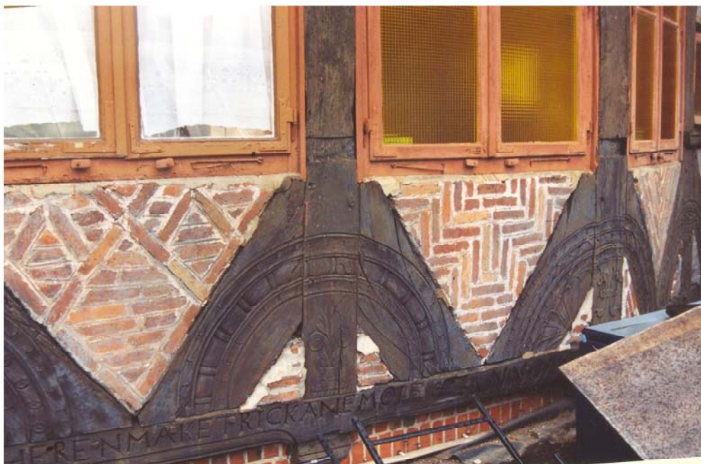
Abb. 126 Grapengießerstraße 12, 1572 (i), Detail: Schwelle mit Schiffskehle, Zierverbände
