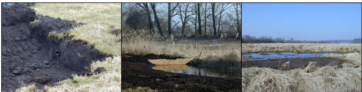
Abb. 3-7: Wiedervernässungsmaßnahmen der ersten Stufe des Maßnahmenplanes zur Aufhebung der Binnenentwässerung, a. Aufnahme von Drainagen, b. Aufstau von Gräben, c. Abflachung von Mulden.
