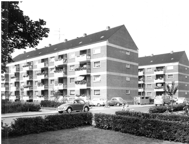
Abb. 19: Wohnzeile der 1960er Jahre mit eingezogenen Balkonen
