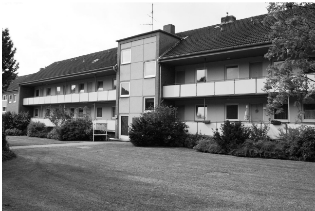
Abb. 22: Wohnzeile mit Altenwohnungen der 1960er Jahre in Lübeck-Kücknitz
