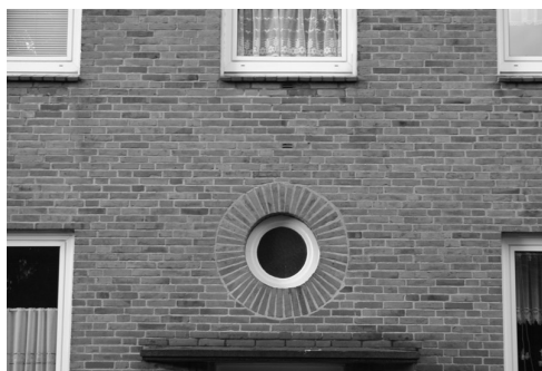
Abb. 46: Zeitgenössisches Detail einer Verblendfassade
