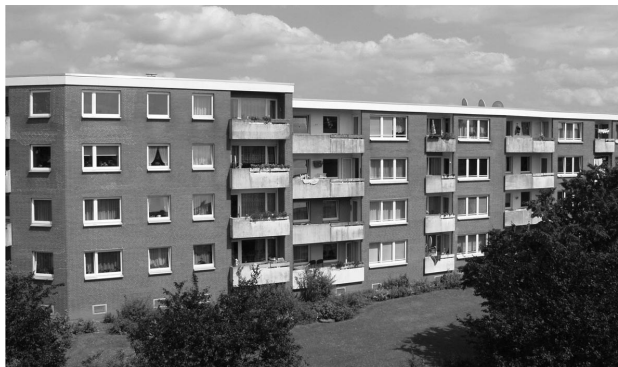
Abb. 18: Wohngebäude der späten 1960er Jahre mit Flachdach und Verblendsteinfassade Quelle: Eigene Aufnahme.
