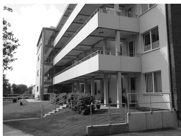
Abb. 120: Fahrstuhl nachrüstung Adlershorst Marienhöhe Quickborn (l.) und Frank Heimbau Laubengang vor Gebäude in Eckernförde-Wilhelmstal Quelle: Eigene Aufnahmen
