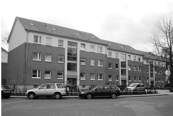
Abb. 121: Beispiel einer Fassadengliederung nach Wärmedämmung und Neuverblendung Quelle: Eigene Aufnahme
