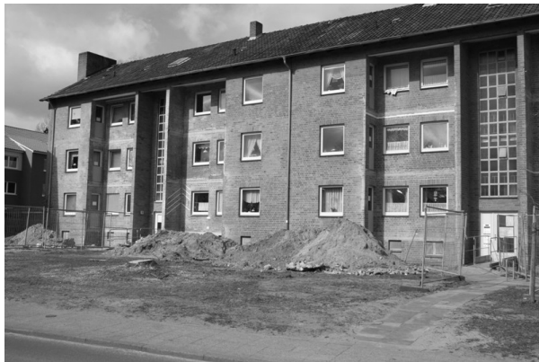
Abb. 48: Vollständige Entfernung der Loggien zur nachträglichen Wärmedämmung an einem Wohngebäude in Lübeck-St. Jürgen
