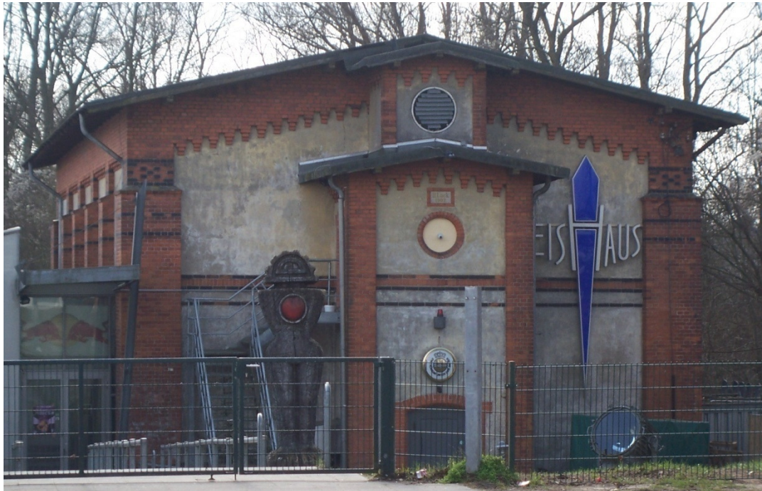
Abb. 73: Ehemaliges Eishaus der Brauerei Lück
