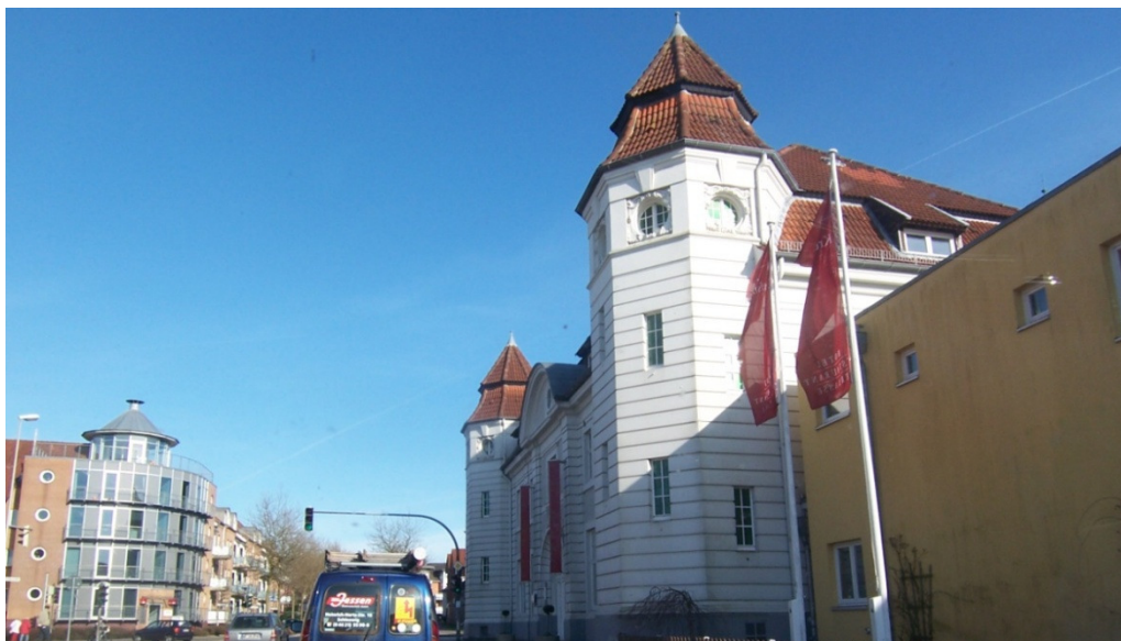
Abb. 88: Straßenseitige Fassade des ehemaligen Kreisbahnhofes
