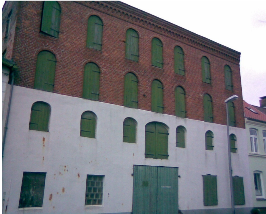
Abb. 77: Speicher der ehemaligen Räucherei Nachtigal im Jungfernstieg 119
