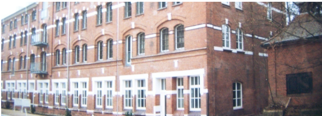
Abb. 58: Ehemaliges Trafogebäude westlich der Brotfabrik
