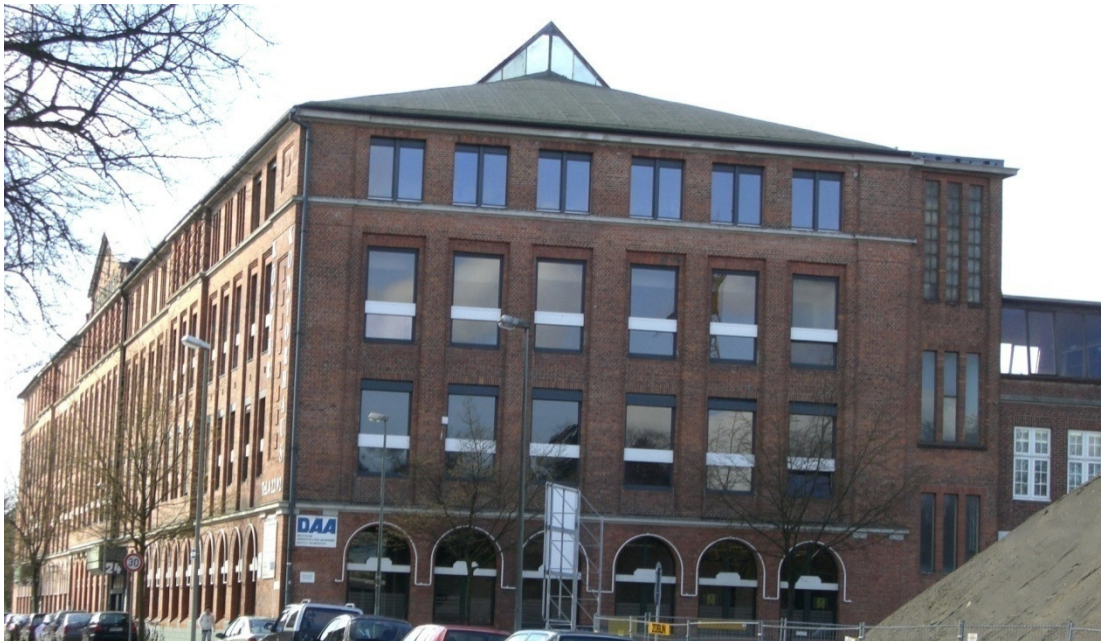
Abb. 22: Tuchfabrik Köster, Neumünster
