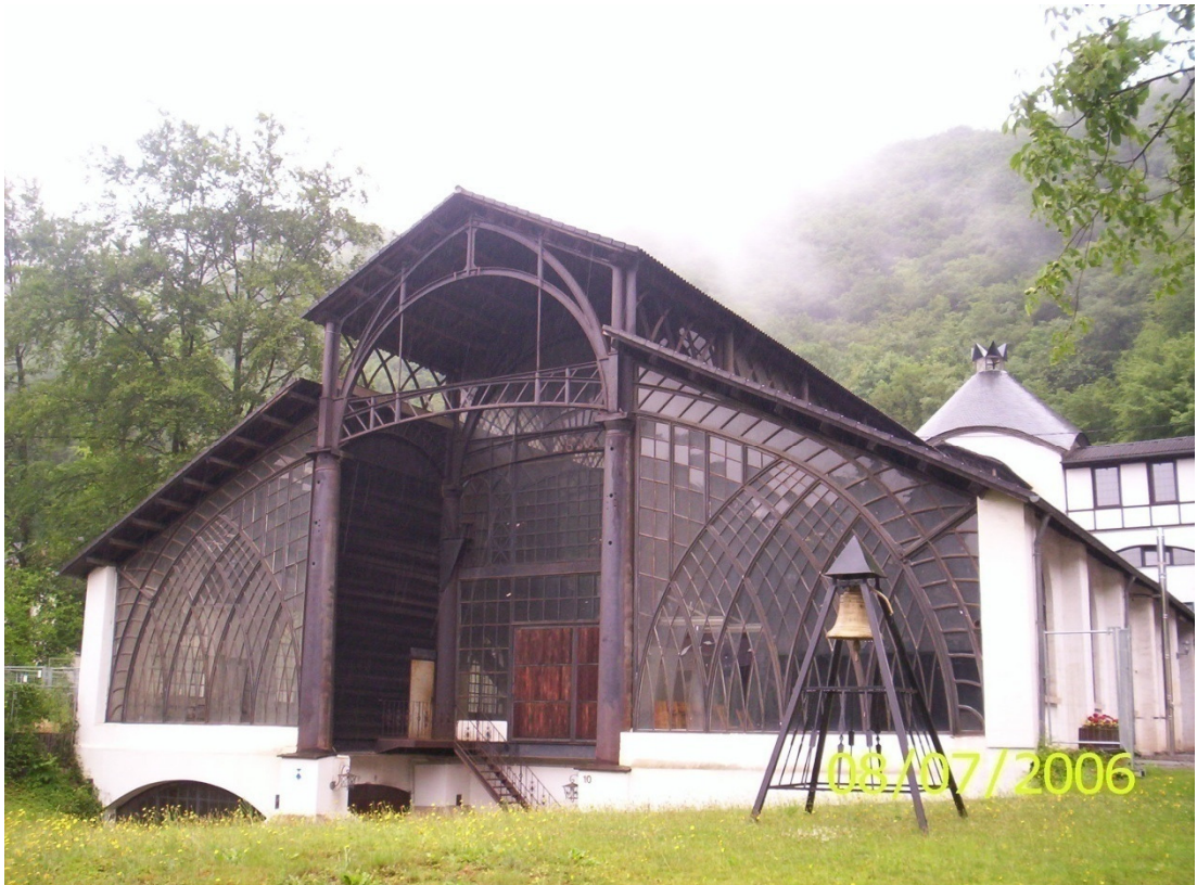
Abb. 3: Gießhalle der Sayner Hütte, Außenansicht
