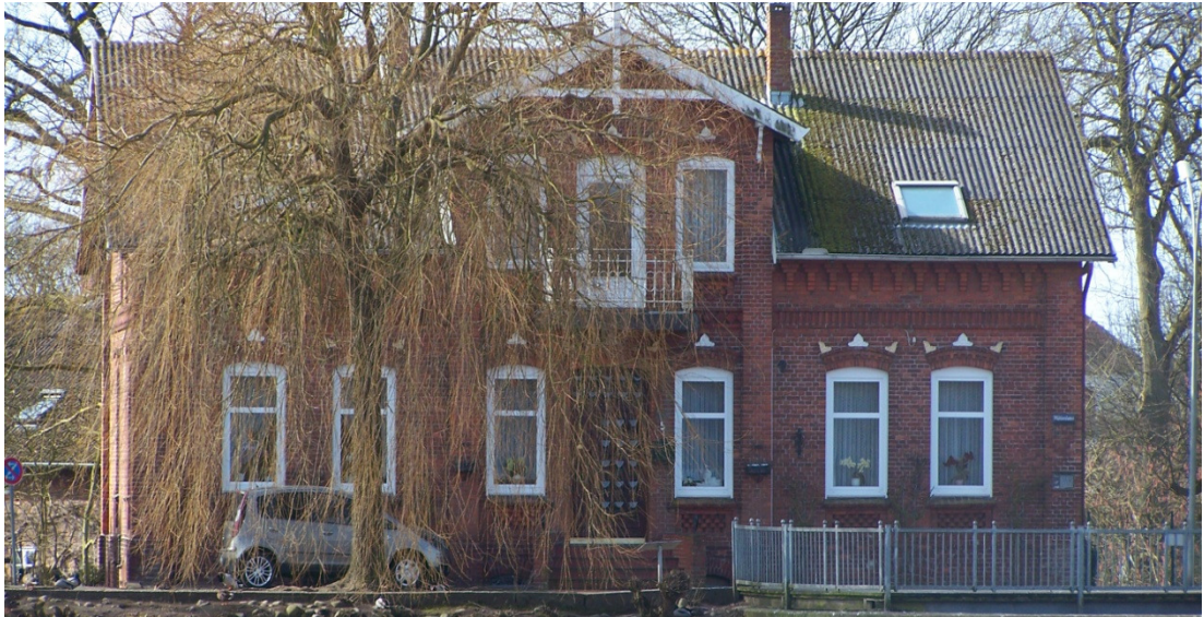
Abb. 37b: Ehemalige Wassermühle Bredstedt, Am Mühlendamm 5 (Wasserseite)
