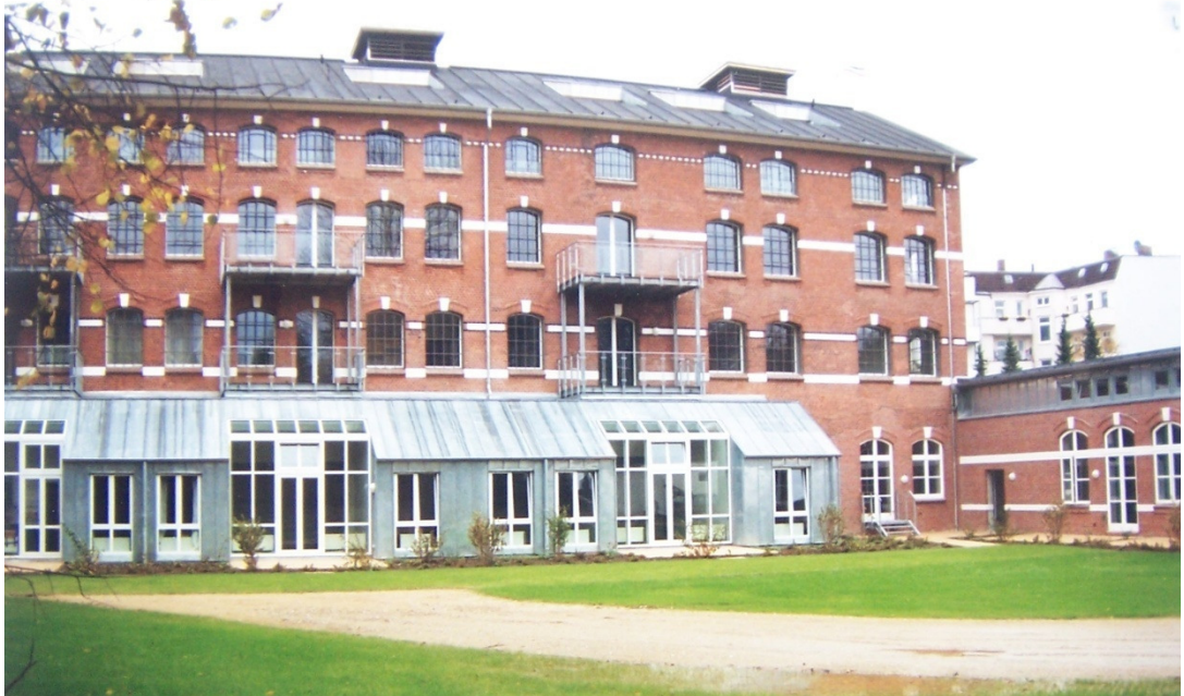
Abb. 60: Südfassade der ehemaligen Brotfabrik
