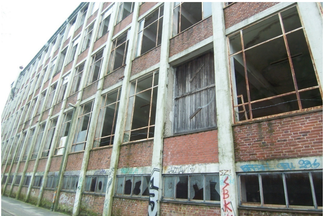
Abb. 68: Ehemalige Tuchfabrik, jüngerer Bauteil (ohne Nutzung)
