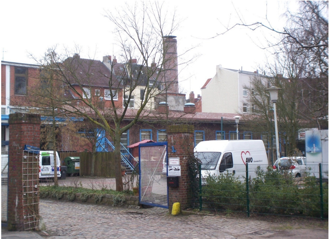
Abb. 14: Ehemalige Räucherei Mahrt, Kiel
