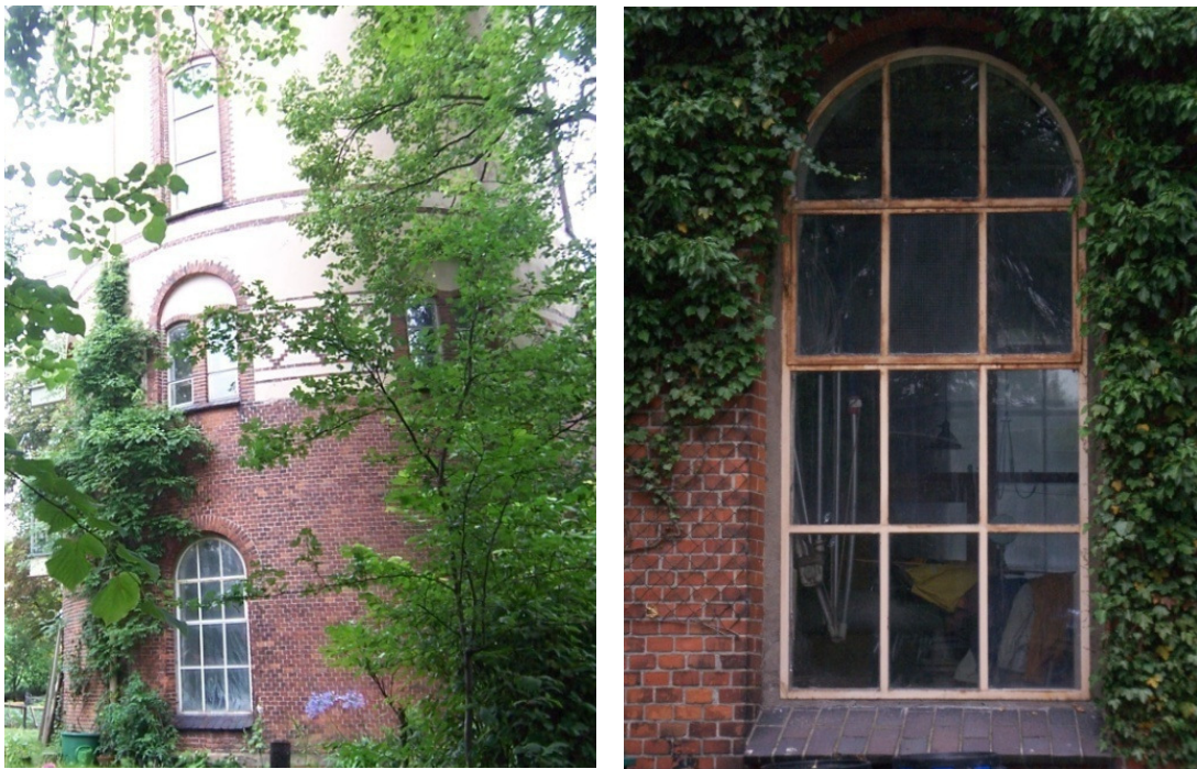
Abb. 101a und 101b: links: Fenster im Erdgeschoss; rechts: Detail
