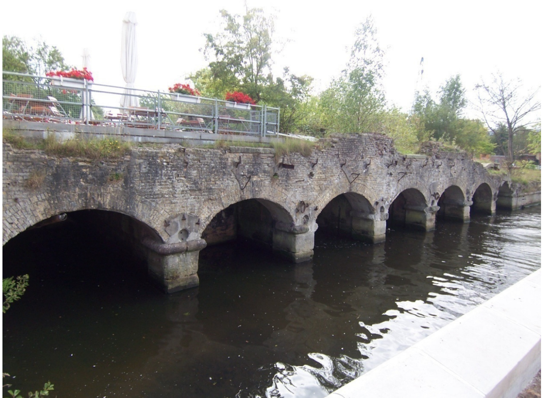
Abb. 41: Gewölbe der ehemaligen Langeschen Mühle über der Schwentine
