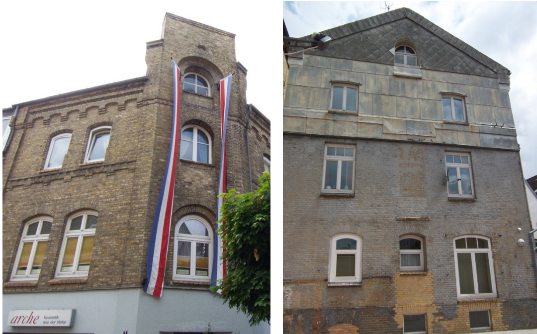
Abb. 36a und 36b: Schleifmühle in Rendsburg; links: Straßenseite, rechts: Rückansicht
