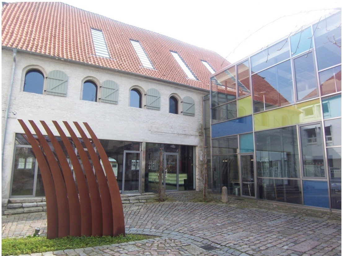
Abb. 80: Anbau im rückwärtigen Bereich des Speichers mit Durchbruch
