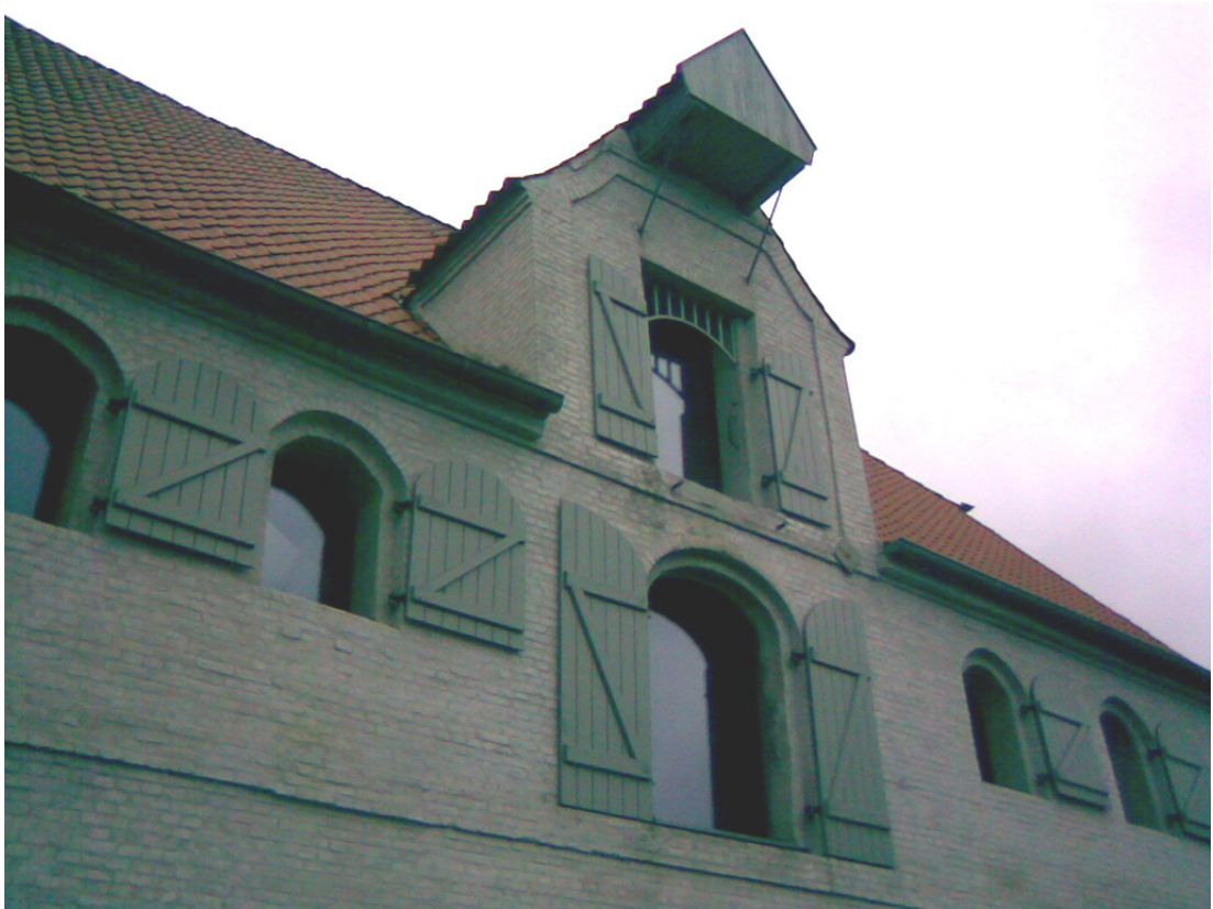
Abb. 81: Ostfassade mit neuen Fensterelementen und Läden
