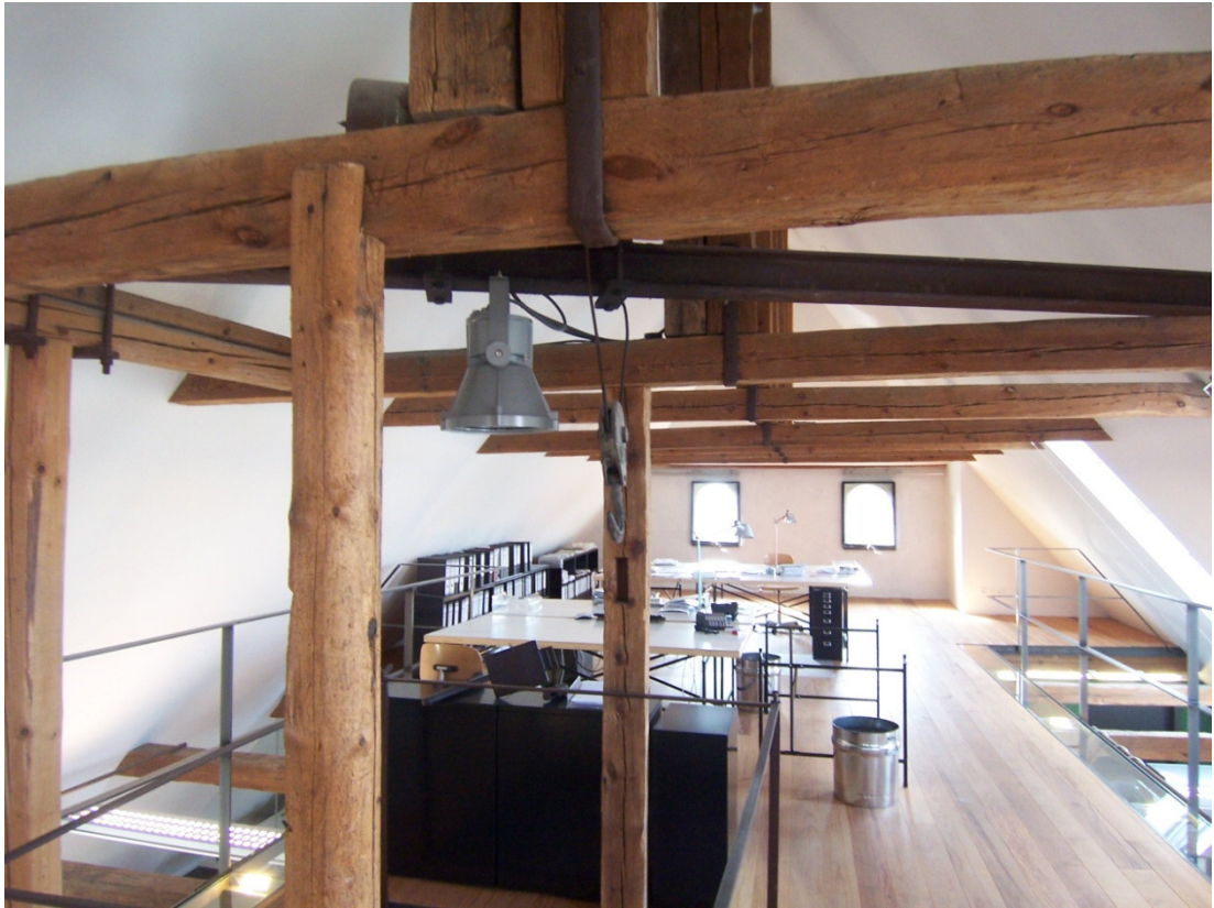
Abb. 84a: Innenansicht: Büroplätze auf der Galerie
