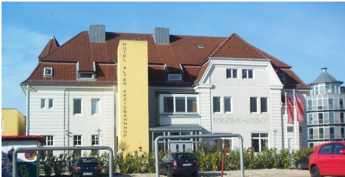
Abb. 89: Rückwärtige Fassade des ehemaligen Kreisbahnhofes
