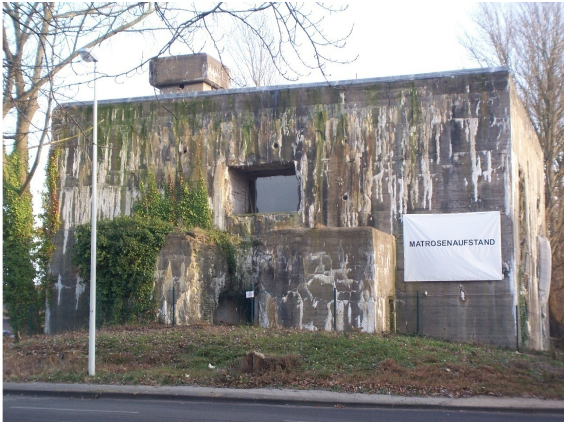
Abb. 32: Flandernbunker in Kiel, heute Ausstellungs- und Veranstaltungsraum
