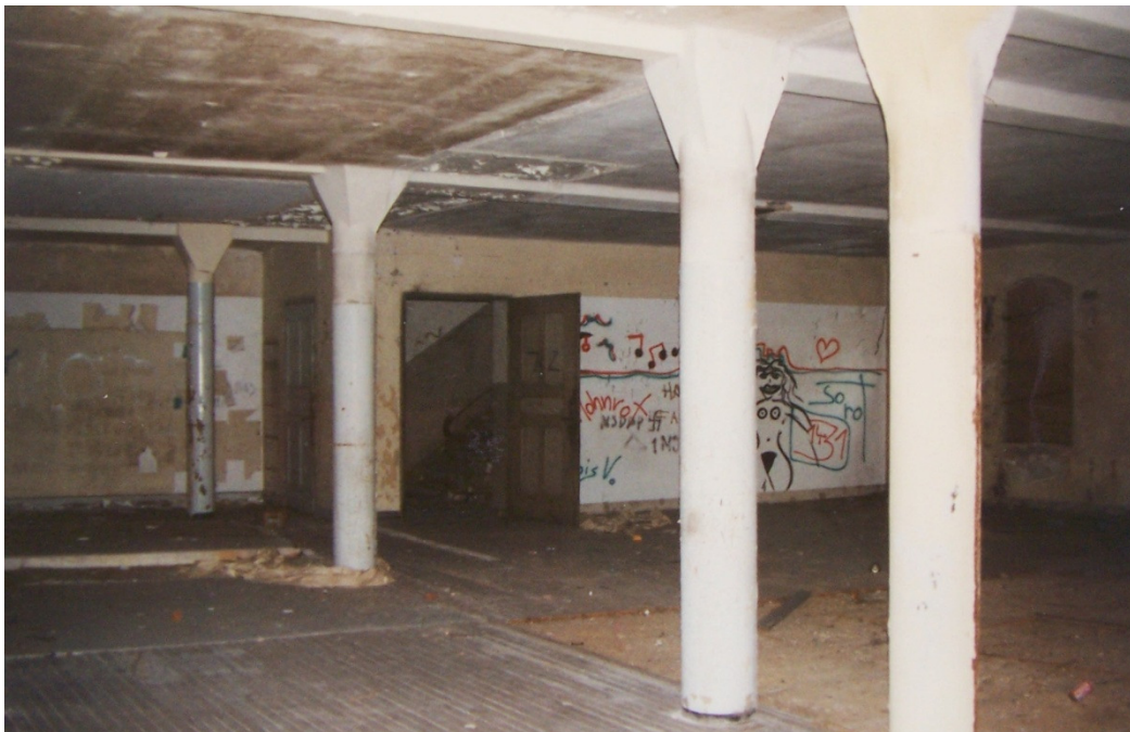
Abb. 59: Innenansicht, 1. Obergeschoss Fabrikgebäude
