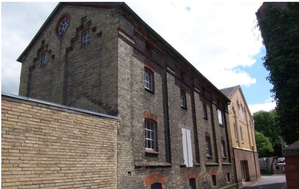
Abb. 69: Fabrikationsgebäude der ehemaligen Baukeramikmanufaktur, Ansicht Gerbergang
