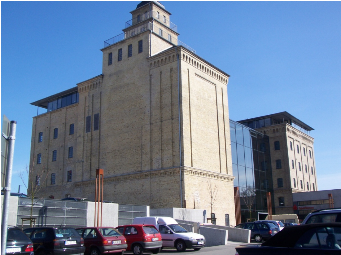
Abb. 46: Die Walzenmühle heute (vom Schwedengang aus gesehen)
