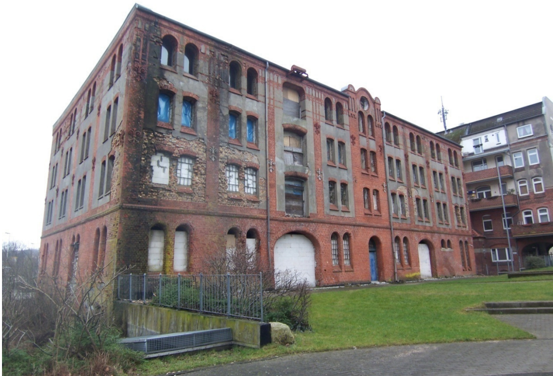
Abb. 10: Ehemaliger Hass-Speicher am Schwedendamm, Kiel
