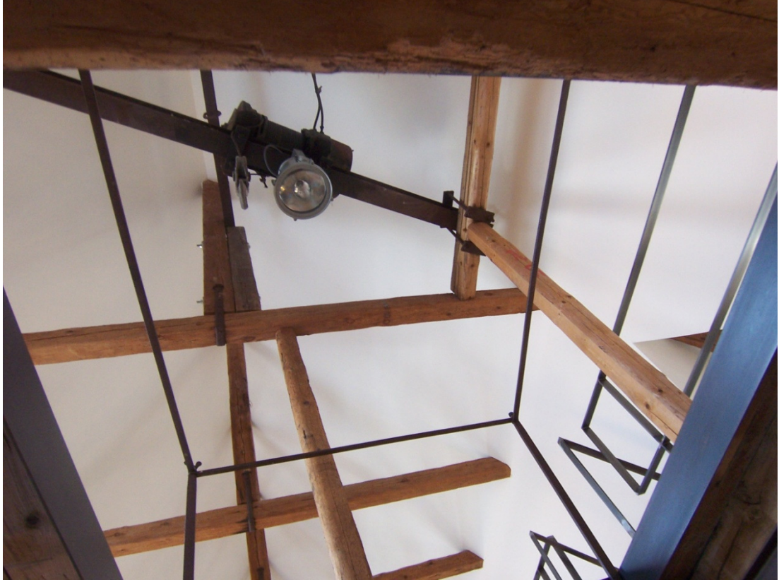
Abb. 82: Ehemalige Deckenöffnungen für den Flaschenzug (noch funktionstüchtig)
