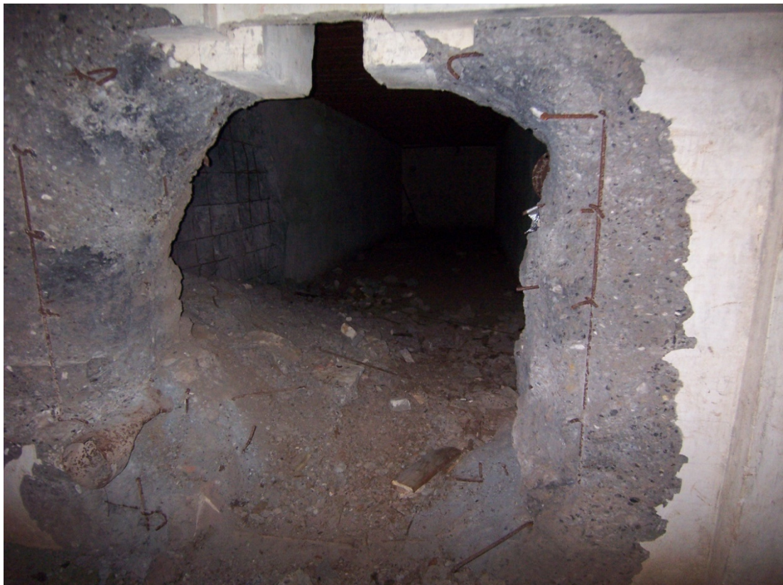
Abb. 31: Bunker in Hanstholm (DK) nach Sprengung
