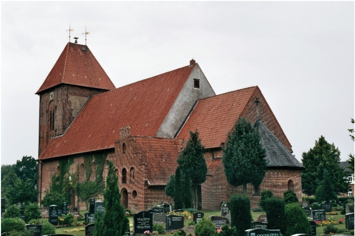
Abb. B.7 Mildstedt. Gegen 1200 begonnen und in mehreren Abschnitten in Backstein errichtet.
