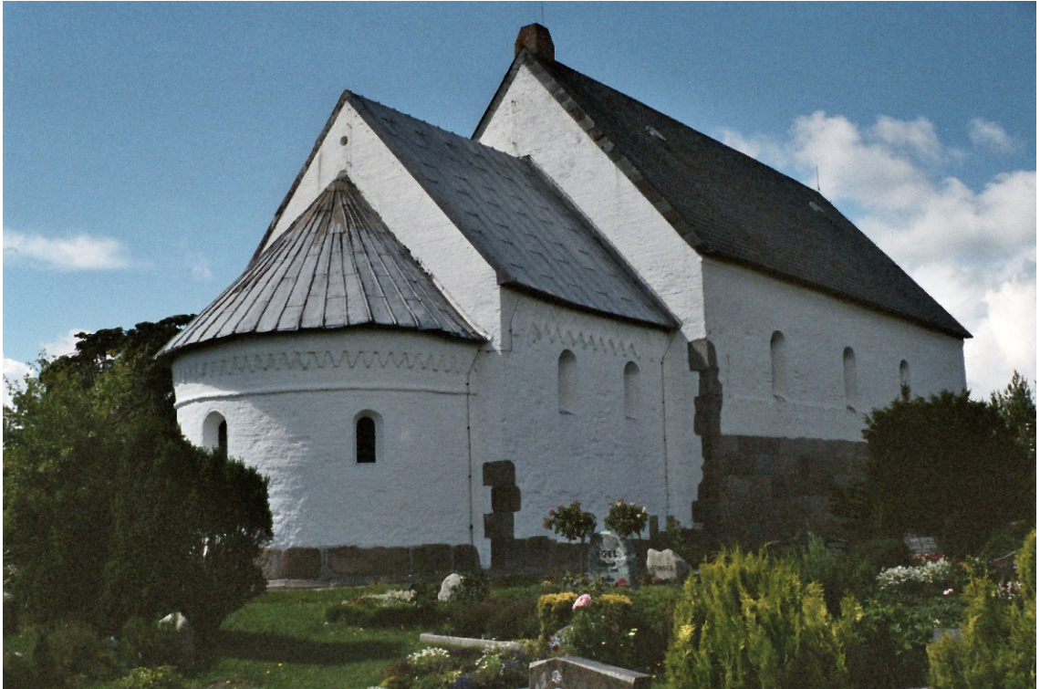
Abb. B.11. Morsum/Sylt. Einheitlicher Mischbau des frühen 13. Jahrhunderts. Sockel aus Granitquadern, am Schiff darüber Feldstein, Tuff und Backstein.
