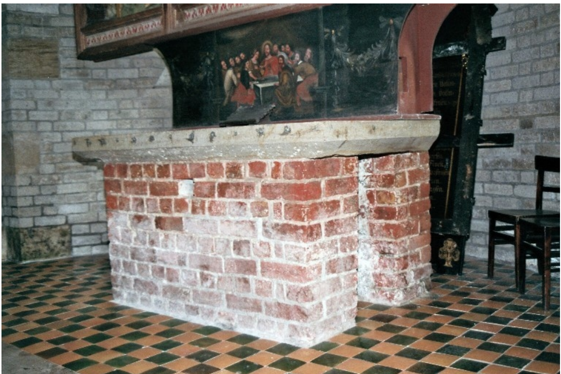
Abb. 1.2. Pellworm, Alte Kirche. Spätes 12. Jh. Sandstein-Mensa, Sepulcrum vorne mittig im Stipes; seitlich Stipeskammer.
