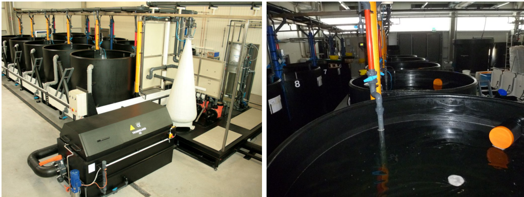
Abbildung 2.4: Kreislaufsystem mit Wasseraufbereitungsanlage. 2
