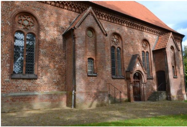
Abb. 169, Lebrade, um 1700, Außenansicht von Süden mit Treppenanbauten für die Logen
