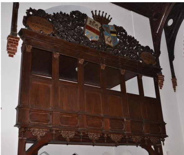
Abb. 198, Patronatsloge, von Abercron, Hansühn, 1896, Fassade vor dem Logenanbau im Norden
