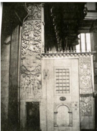
Abb. 4, Kiel, Nikolaikirche, Rantzau-Gestühl, 1543, Historische Aufnahme vor 1884
