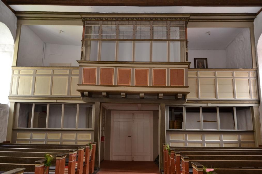
Abb. 109, Logenanlage im Westen, Westensee, 20. Jahrhundert
