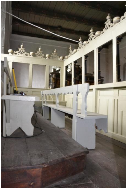
Abb. 159, Abbildung 118, Patronatsloge, von Bülow, Gudow, 1583-95, Innenraum, Obergeschoss von Westen
