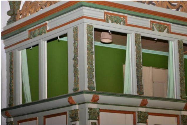
Abb. 131, Patronatsloge, Lütjenburg, 1735, "Helmstorfer-Loge", Fensterzone
