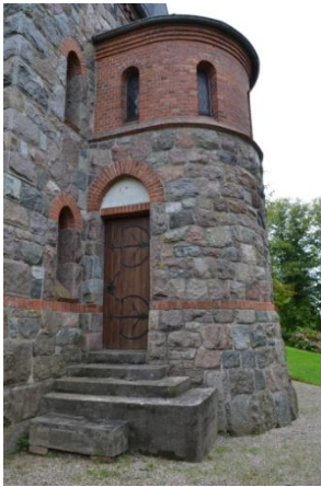
Abb. 199, Treppenanbau im Süden, Hansühn, 1896
