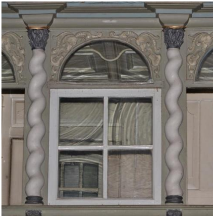
Abb. 112, Patronatsloge, v. Reventlow, Lütjenburg, Fensterzone
