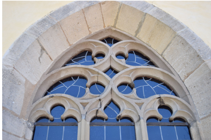
Abb. 26 Denkendorf, Propsteikirche St. Pelagius. Fenstermaßwerk des nördlichen Seitenschiffs.
