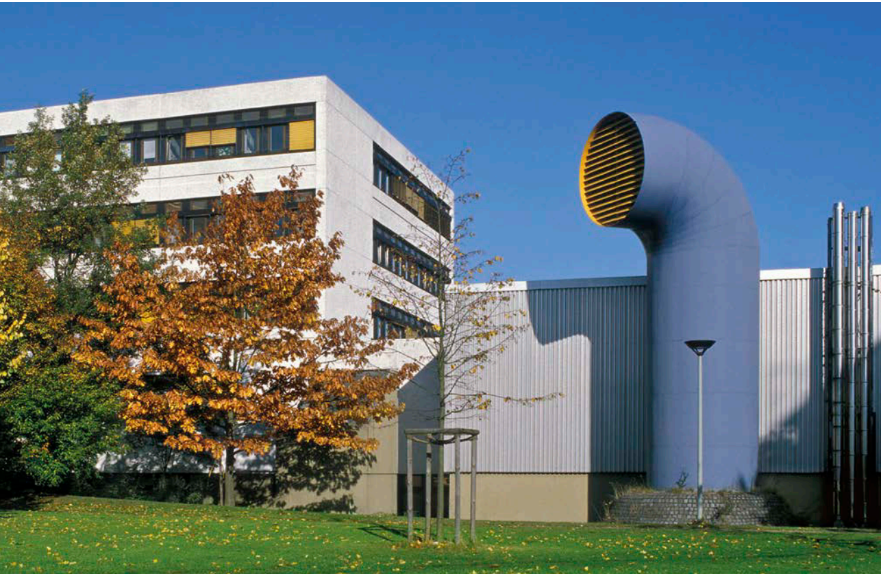
Das Gebäude des Instituts für Informatik in der Hermann-Rodewald-Str. 3, in dem ein Teil des Instituts in unmittelbarer Nähe zu Rechenzentrum und Präsidium untergebracht ist
