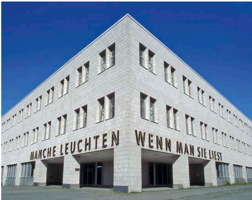
Der Neubau der Hauptabteilung in der Leibnizstr. 9: Blick auf den Haupteingang
