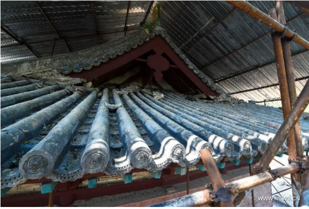
Abbildung 40: Ansicht der seitlichen Dachtraufe des Dayunyuan-Tempels in Shanxi, China, während der Sanierung 2015. Wädāng und huābiānwǎ bilden zusammen die dekorative Dachtraufe (Foto: Xinhua, http://www.china.org.cn/arts/2015-08/28/content_36443170.htm ).
