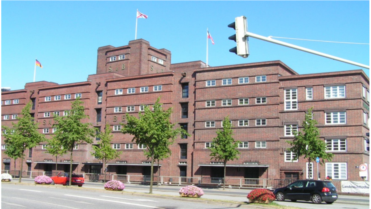
Abb. 242 Sartori-Speicher, Kiel, Wall 47-51, 1925/26 von Ernst Stoffers (Foto 2006)
