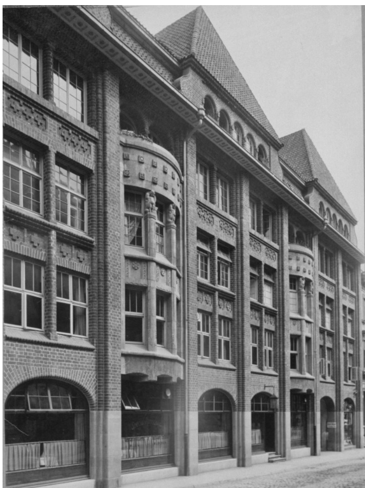
Abb. 245 (Kat. 24) Fassade des Thöl-Hauses von 1908 (Bildarchiv Foto Marburg 12614)
