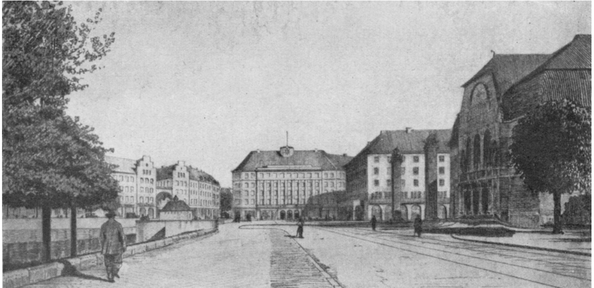
Abb. 228 Städtebaulicher Wettbewerb Kleiner Kiel, Beitrag Carl Meyer, Blick vom Stadttheater Richtung Holstenbrücke, mit "Kehdentor" (Aus Hahn, DBZ, 1927)
