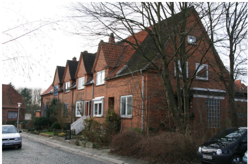
Abb. 196 (rechts) (Kat. 53) Rosenfelder Straße 20-30 (Foto 2007)
