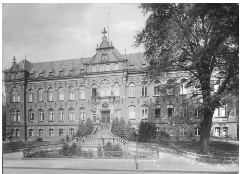
Abb. 87 Verwaltungsgebäude der Invaliden- und Altersversicherungs- Anstalt Schleswig- Holstein, Gartenstraße, Kiel, 1895 von Wilhelm Voigt (StAK Fotosammlung 65980)
