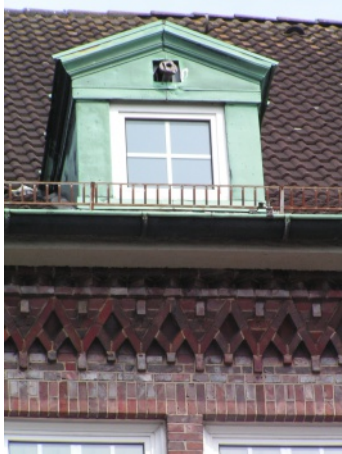
Abb. 235 (Kat. 75) Gaube und Traufgesims der Sparkasse Wellingdorf, 1927 (Foto 2007)
