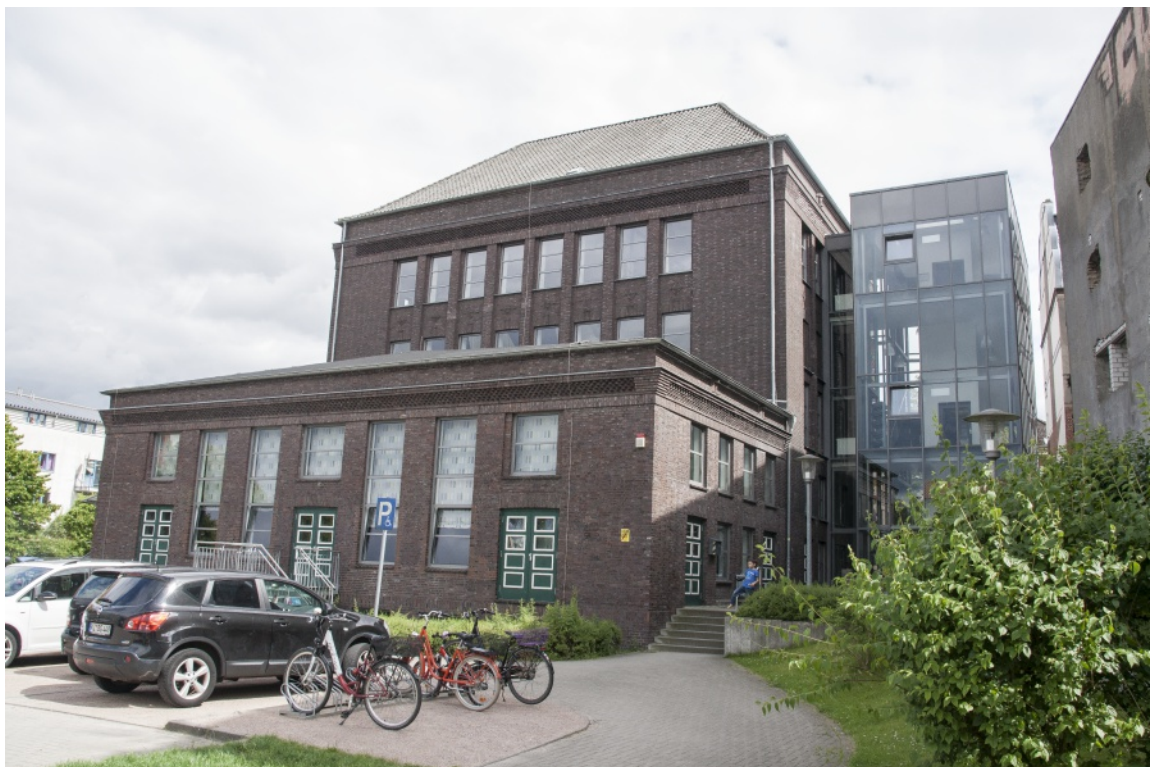
Abb. 263 (Kat. 78) Ehemaliger Milchhof, 2006 saniert und als städtische Musikschule eingerichtet, mit gläsernem Anbau für Treppe und Aufzug (Foto 2017)
