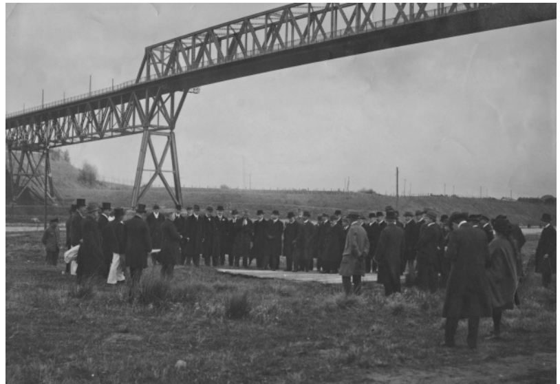
Abb. 214 (Kat. 66) Grundsteinlegung für den Getreidesilo am Nordostseekanal, 1921 (Foto Nachlass)
