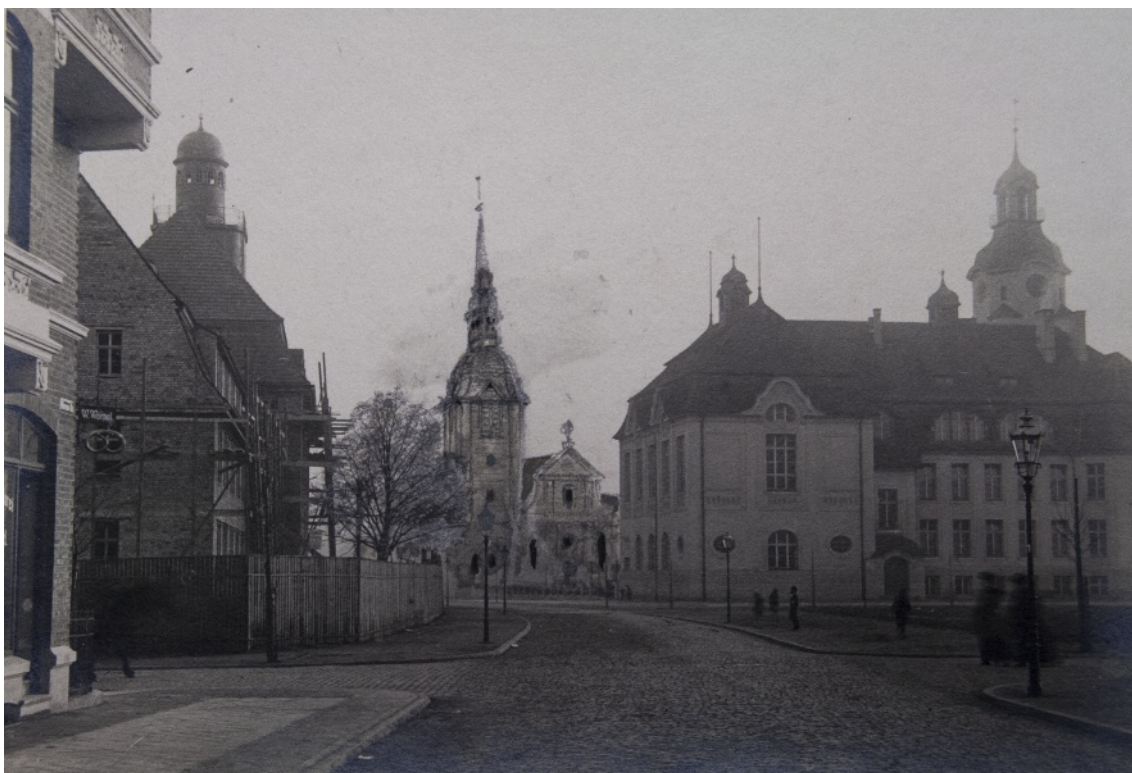
Abb. 206 Retuschiertes Foto aus dem Hochbauamt, um 1908 Harmsstraße in Richtung Schützenpark mit dem Stadtkloster (im Bau) links und der Höheren Mädchenschule rechts (Aus der Akte StAK 23302)
