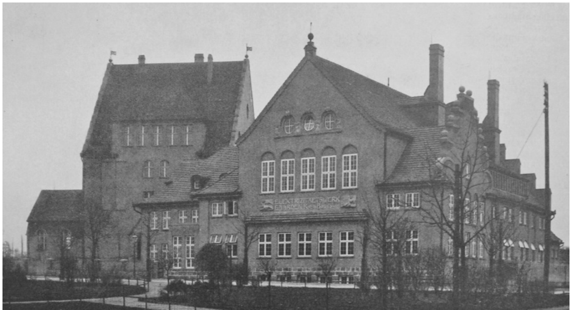
Abb. 143 (Kat. 33) Elektrizitätswerk Gaarden-Süd (1909/10), links dahinter die Volksschule (Aus Der Baumeister 10 (1912), S. 77)
