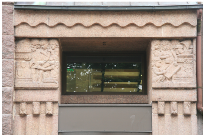
Kat. 18 (Foto 2007) Westholsteinische Bank Heide, 1907, Detail des Portals. Siehe auch Abb. 117, 119
