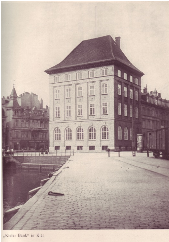
Abb. 209 (Kat. 59) Kieler Bank am Bootshafen, fertiggestellt 1917 (Aus Groth 1921)
