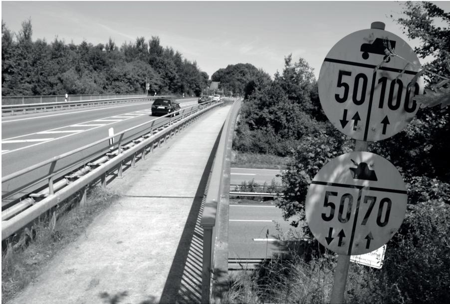
Abb. 17: Beschilderung der zulässigen Militärischen Lastenklasse für Rad- und Kettenfahrzeuge an Brückenbauwerken
