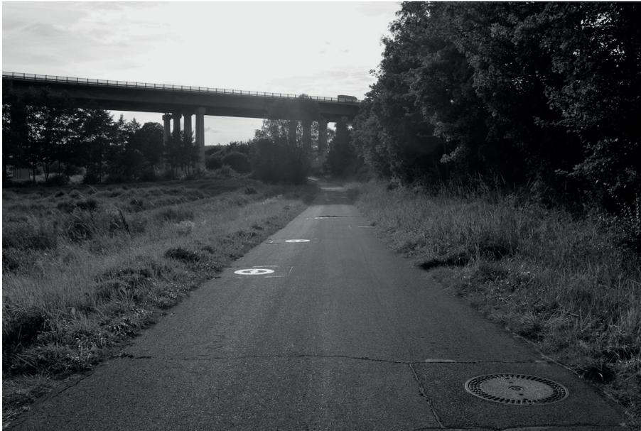
*Abb. 11: Minenzellensperre: unter den Abdeckungen befinden sich kleine Kammern zur Aufnahme von Panzerminen, die im Einsatz eingesetzt und anschließend getarnt werden
