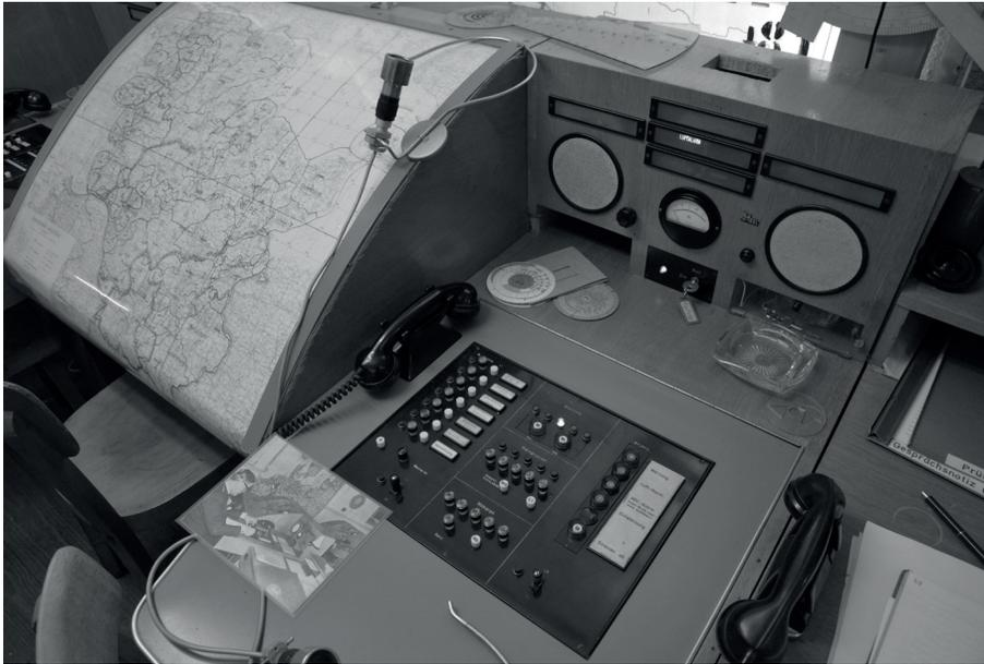
Abb. 31: Bedientableau zur Auslösung von ABC-Alarm über die Luftschuttsirenen
