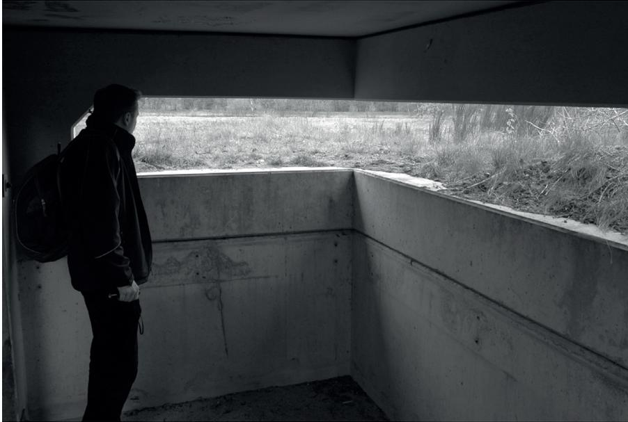
Abb. 22: Stellung mit Schießscharten am Ende eines unterirdischen Ganges
