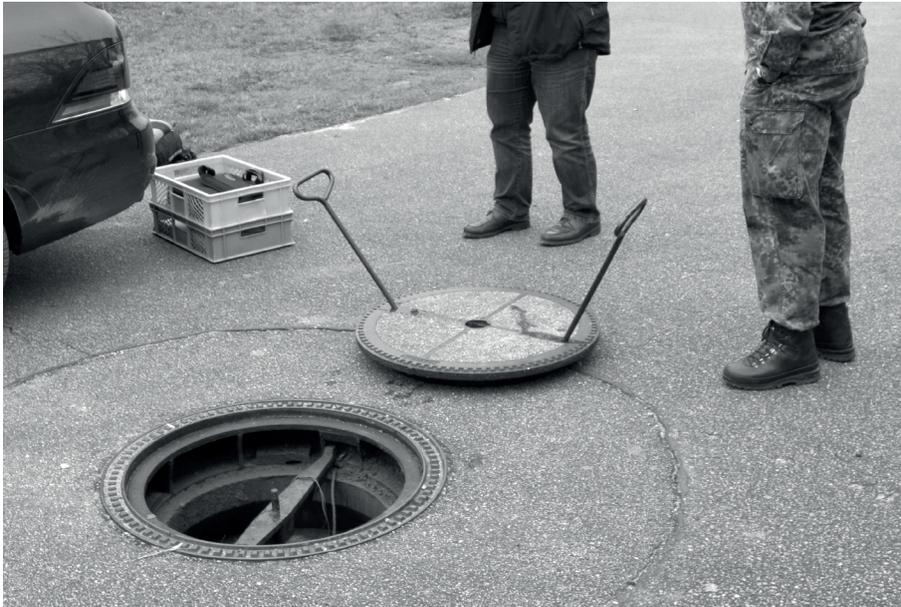
Abb. 24: Demontierter „Sprengdeckel“ vom Sprengschacht einer sogenannten Trichtersperre
