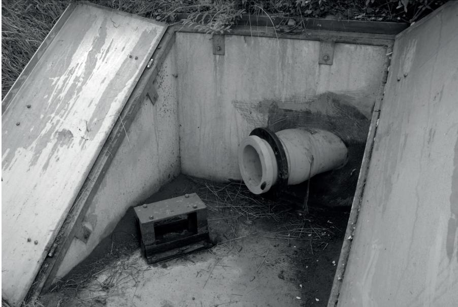
*Abb. 10: Zugang zu einer unterirdischen Röhre einer Grabensperre, die im Einsatzfall mit Sprengstoff gefüllt worden wäre*
