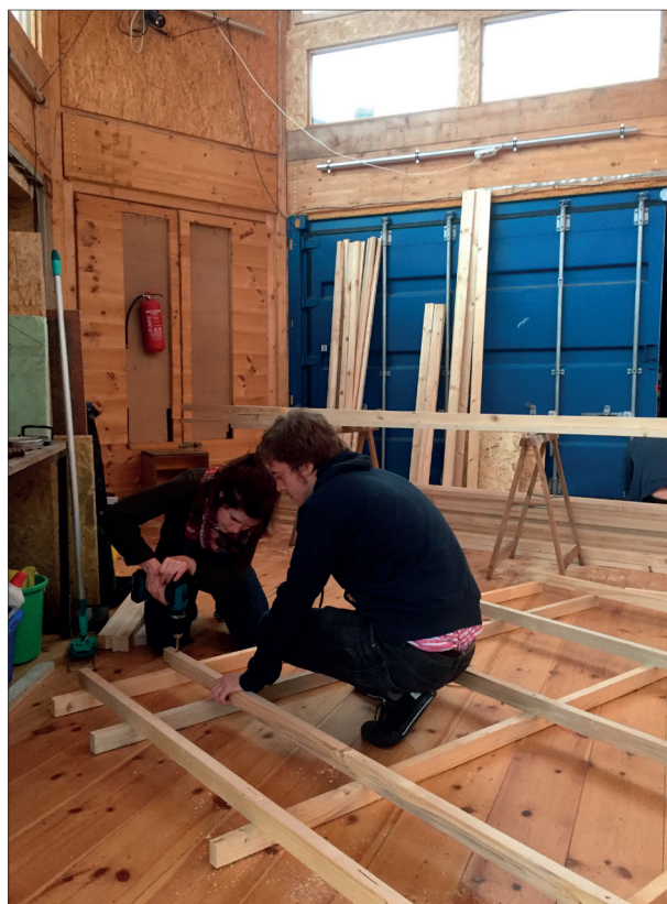
Abb. 11: Das Verschrauben
