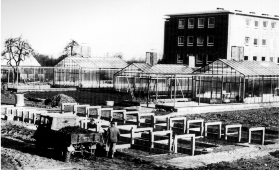
Abb. 19: Gewächshaus-Anlage der Institute Pflanzenbau sowie Pflanzenernährung und Bodenkunde (etwa 1962). Vorne: Bau der Lysimeter-Anlage mit Böden Schleswig-Holsteins). Quelle: N. Knauer.
