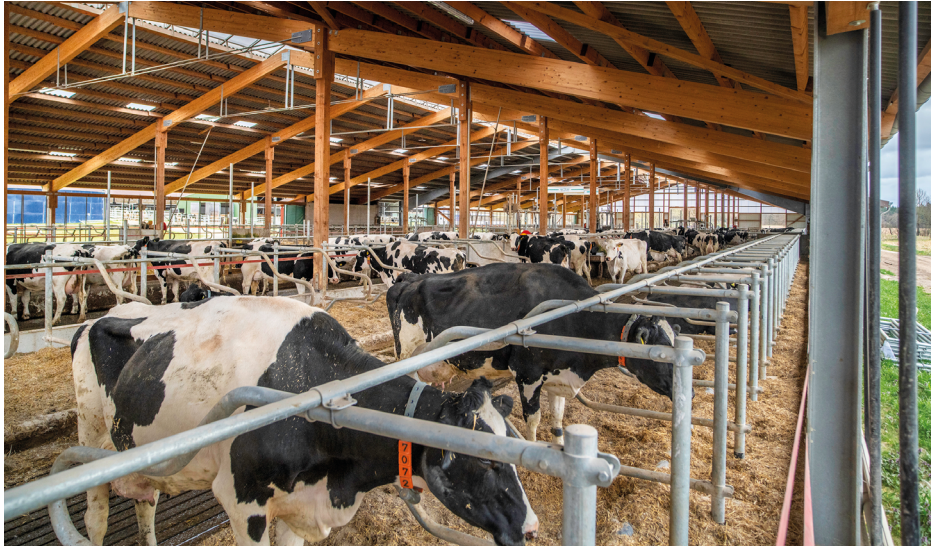
Abb. 43: Ein Teil des neuen Stalls verfügt über einen Bodenbelag aus Gummi für mehr Tierkomfort sowie Einrichtungen zur Reduktion umweltrelevanter Gase. Quelle: H.D. Habbe.
