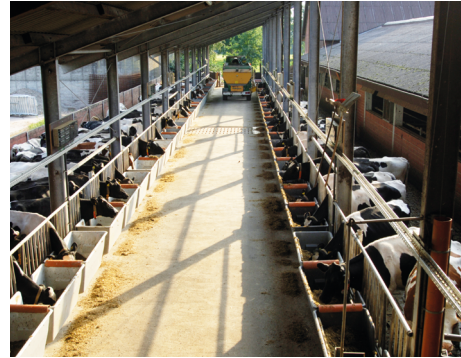
Abb. 45: Auf Karkendamm (alter Stall) stehen elektronische Wiegetröge zur Verfügung, die die tägliche individuelle Futteraufnahme erfassen. Quelle: H.D. Habbe.
