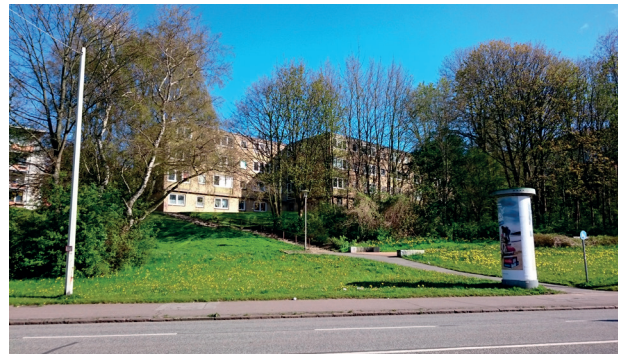
Abb. 30: Blick auf das Quartier Sandkrug im Frühjahr von der Werftstraße aus
