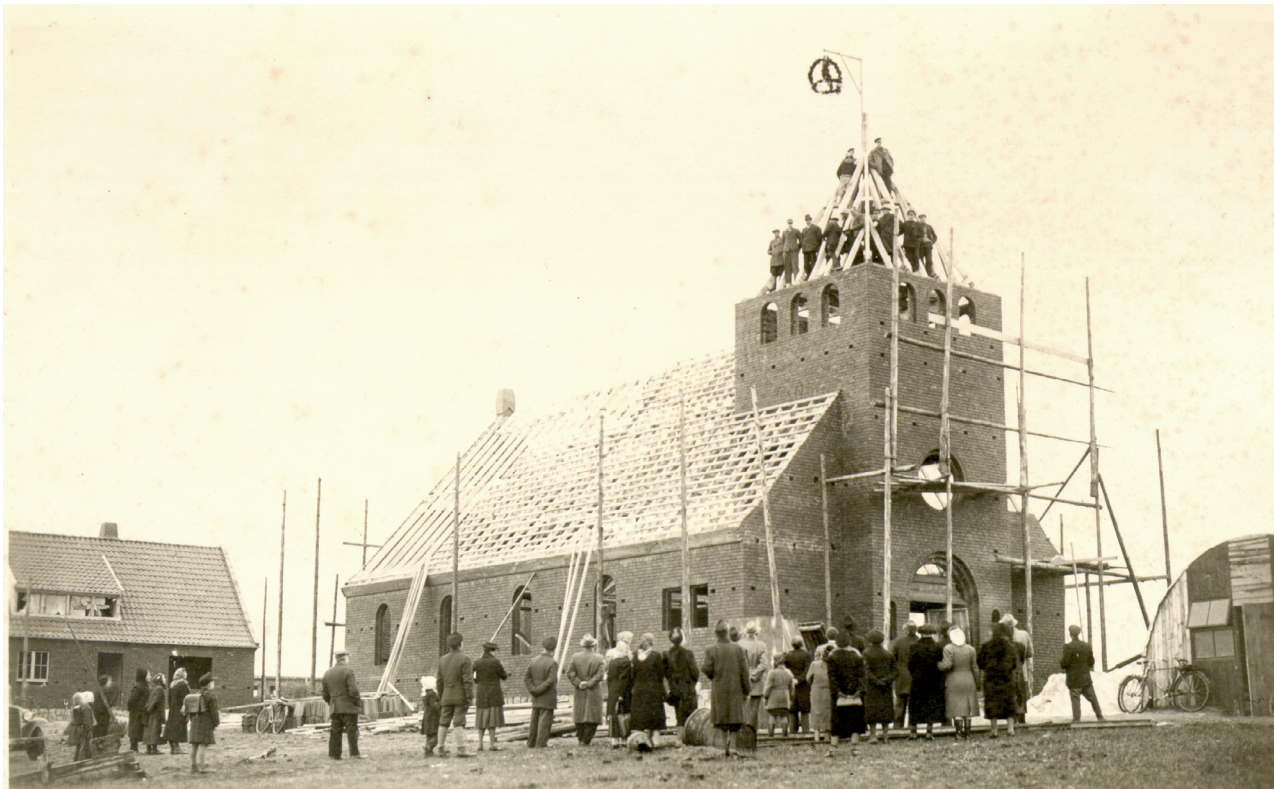
Abb. 52: An der 1949/50 erbauten katholischen Kirche Bordesholms wird Richtfest gefeiert. Alle Rechte vorbehalten. Quelle: KVBL.
