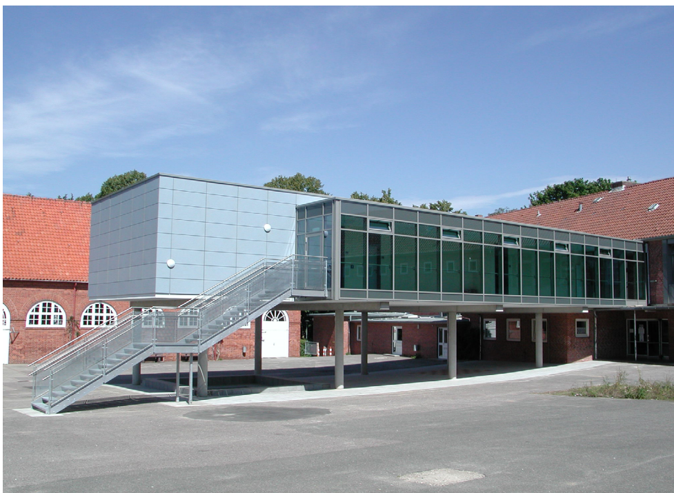
Abb. 71: Durch einen ›gestelzten‹ Erweiterungsbau entstanden 2005 dringend notwendige zusätzliche Klassenräume an der Hans-Brüggemann-Realschule. Alle Rechte vorbehalten. Quelle: Architekturbüro Ladwig.
