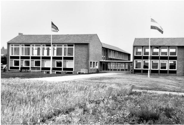
Abb. 67: 1959 als Volksschule eingeweiht, sind die Gebäude am Langenheisch nach etlichen Um- und Erweiterungsbauten heute Standort der Hans-Brüggemann-Gesamtschule. Alle Rechte vorbehalten. Quelle: KVBL.
