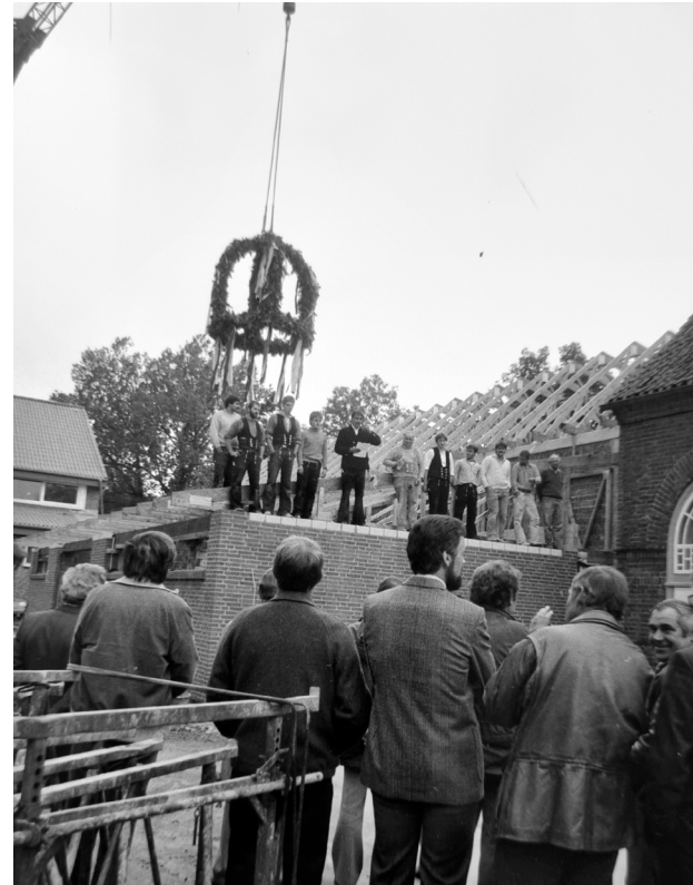
Abb. 70: Das Richtfest für die neue Sporthalle der Realschule im Jahr 1987. Alle Rechte vorbehalten. Quelle: KVBL.
