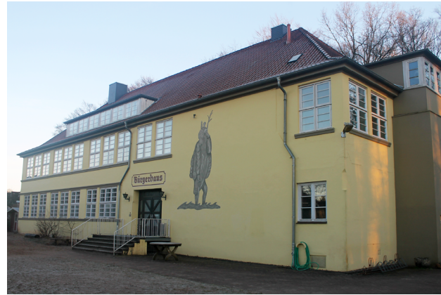
Abb. 68: Im »Bürgerhaus« war in den 1950er Jahren die Mittelschule untergebracht. Aufnahme von 2022. Foto: CAB. Alle Rechte vorbehalten.
