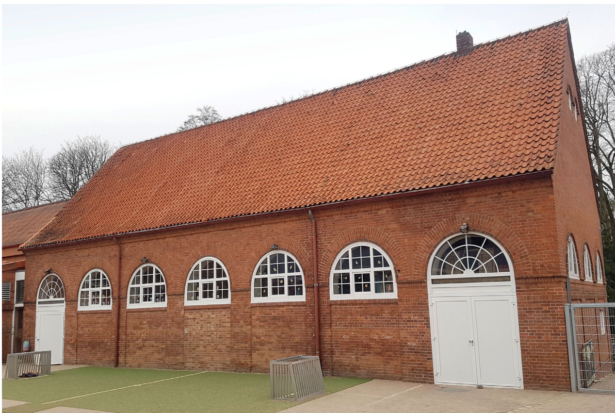
Abb. 27: Alte Turnhalle in der Schulstraße. Fotografie von Jan Ocker. Alle Rechte vorbehalten.
