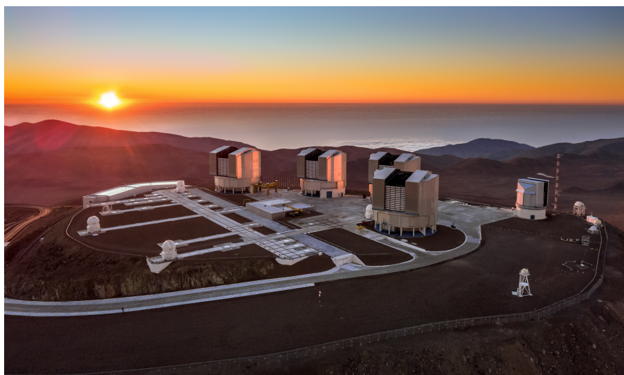
Abb. 2.5: Ansicht des Very Large Telescope (VLT) der ESO auf dem Cerro Paranal. Zu sehen sind die vier Hauptteleskope (UTs) mit einem Spiegeldurchmesser von 8,2 m und die Hilfsteleskope (ATs) mit einem Spiegeldurchmesser von 1,8 m. Das mittelgroße Teleskop rechts im Bild ist eines der beiden VLT Durchmusterungsteleskope (VST) (G.Hüdepohl (atacamaphoto.com)/ESO 2015).
