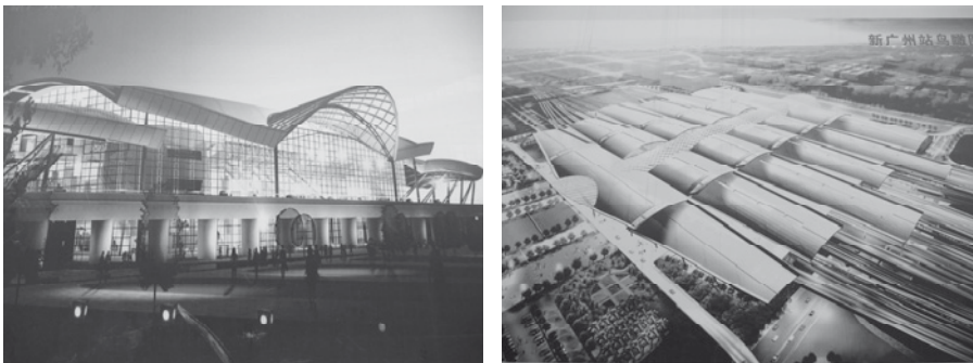
Abb. 43: Planungsentwurf der Eingangshalle (linkes Bild) und des Bahnhofgebäudes (rechtes Bild) der „Guangzhou South Railway Station“ (eigene Aufnahmen 2007 von einem in Shibi Village aufgehängten Informationsplakat)
