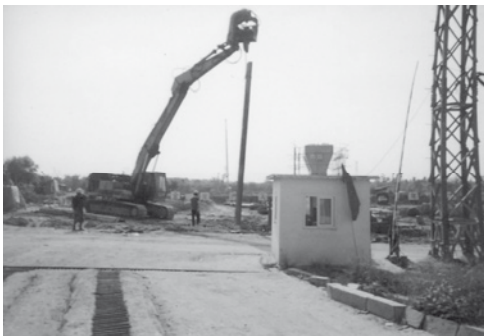
Abb. 78: Baugelände der Guangzhou South Railway Station im Jahr 2008 (Photoaufnahme von einer zehnjährigen lokalen Einwohnerin im Rahmen der Autophotographie-Methode)
