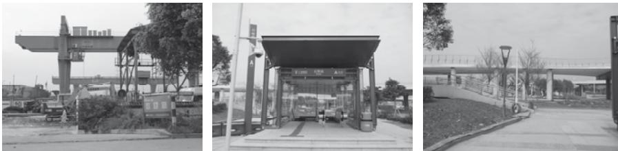
Abb. 71: Das Gelände der Metrostation von Shibi Village im Bauzustand im Jahr 2008 (linkes Bild) und kurz vor der Inbetriebnahme im Jahr 2011 (mittleres und rechtes Bild) (eigene Aufnahmen 2008 und 2011)
