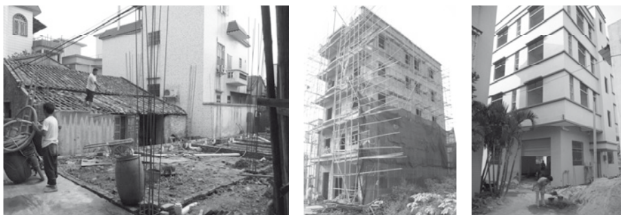
Abb. 64: Abriss traditioneller und Errichtung neuer mehrstöckiger Wohngebäude in Shibi Village (linkes Bild zeigt den Baubeginn des zukünftigen Wohnhauses eines 43-jährigen Interviewpartners) (eigene Aufnahmen 2008 und 2009)
