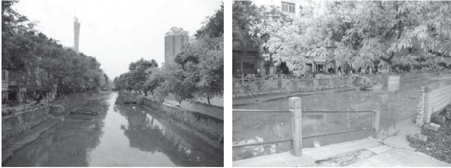
Abb. 84: Der Fluss von Liede und die kurz vor dem Abriss stehende Bebauung entlang der Uferseiten (eigene Aufnahmen 2009)
