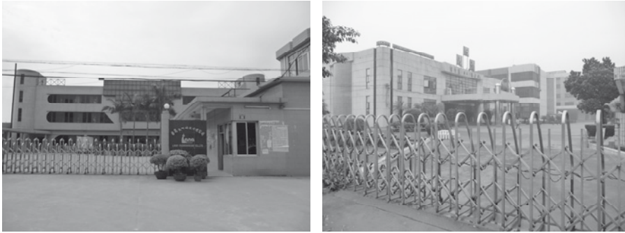
Abb. 50: Die Textilfabrik Lana Fashionwear Co. (linkes Bild) und die Grußkarten produzierende Mooncard-Fabrik (rechtes Bild) entlang der Ausfallstraße in Shibi Dorf 1 (eigene Aufnahmen 2009)
