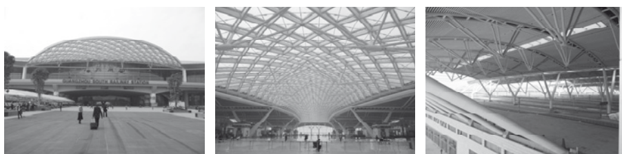
Abb. 44: Eingangsbereich, Bahnhofshalle und Gleisanlagen der „Guangzhou South Railway Station“ im Februar 2011 (eigene Aufnahmen 2011)
