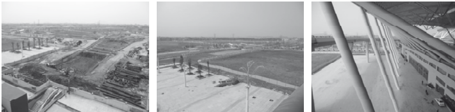
Abb. 45: Baugelände des südwestlichen Entwicklungsgebietes der „Guangzhou South Railway Station“ im Februar 2011 (Eigene Aufnahmen 2011)
