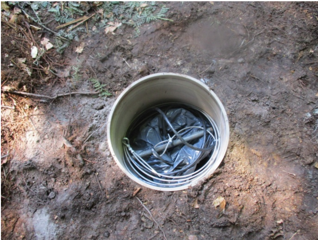
Abbildung 3: verschlossenes Bohrloch nach der Installation. Abschließend wurde das Bohrloch mit einem Deckel verschlossen und einer Steinplatte abgedeckt. (Foto: E. Wetzig, BGR)
