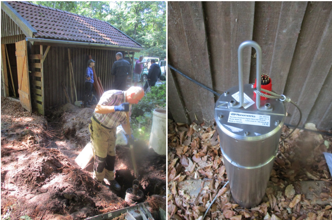
Abbildung 2: (a) Erdarbeiten zur Bohrlochinstallation. Im Vordergrund der Abschluss des Bohrlochs vor der Verrohrung, hinten die Forsthütte in der die Elektronik untergebracht ist. (b) Nanometrics Meridian Breitbandseismometer vor der Installation. (Fotos: E. Wetzig, BGR)
