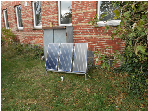
(c) Stromversorgung mit Solarpanelen
