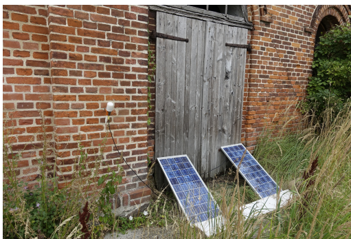
(c) Stromversorgung mit Solarpanelen
