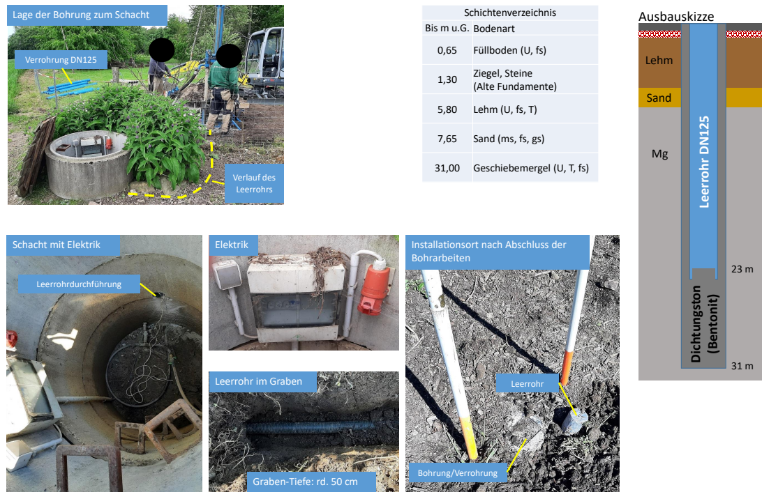
Abbildung 2: Dokumentation der Erdarbeiten zur Erstellung des Bohrlochs der zukünftigen Station Birkenmoor.
