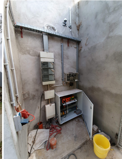
(b) Elektronischschrank mit Digitalisierer (orange), GPS- und Mobilfunkantenne (oben).
