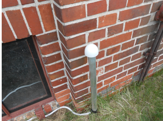
(b) GPS Antenne an der Rückseite des Gebäudes.
