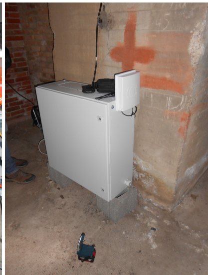
(d) Schaltschrank mit Mobilfunkantenne.
