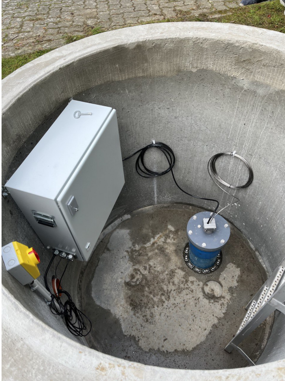
(a) Schacht mit Bohrlochkopf und Schaltschrank.
