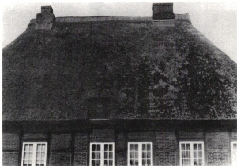
Foto 16: Unterschiedliche Verteilung der Dachvegetation auf linker und rechter sowie oberer und unterer Dachhälfte, Altenholz Kr. Eckernförde, 1.8.69, Aufn. 3
