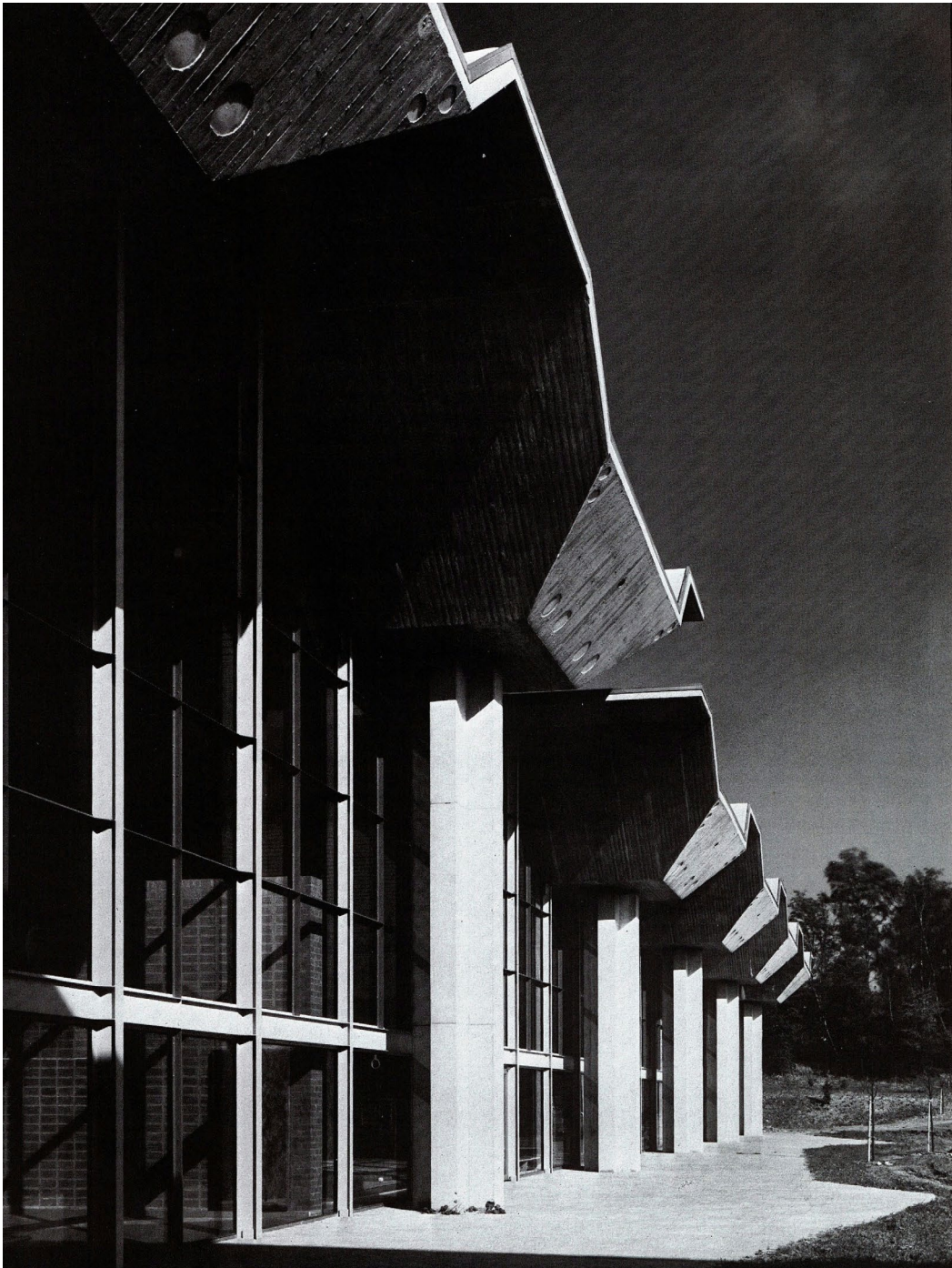
↑ Abb. 7. Sportforum, Tragwerkskonstruktion in Sichtbeton mit Abdrücken der Schalung. Aus: von Gerkan 1978 (wie Anm. 12), S. 205.
