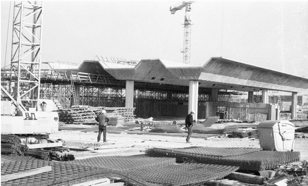
↑ Abb. 17. Sportforum, Baustelle an der Olshausenstraße, Schalung des Tragwerks, offene Lüftungsöffnungen zeigen den Hohlkasten des Trägers. Foto 1973: Friedrich Magnussen, veröffentlicht unter der Lizenz CC BY-SA 3.0 DE . Stadtarchiv Kiel, Fotoarchiv, Sig. 18.259.
